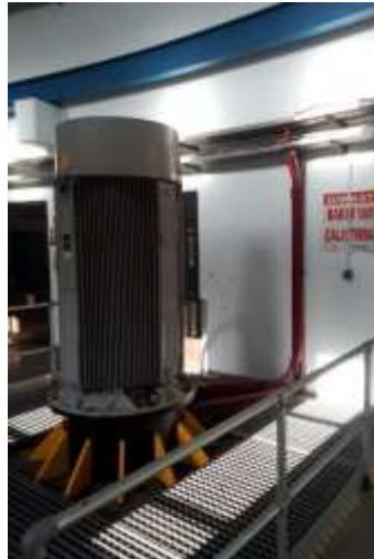
Şekil 3.3: Dikey Milli Tip Santrifüj Pompa Motoru ve Dikey Mil Yapısı
