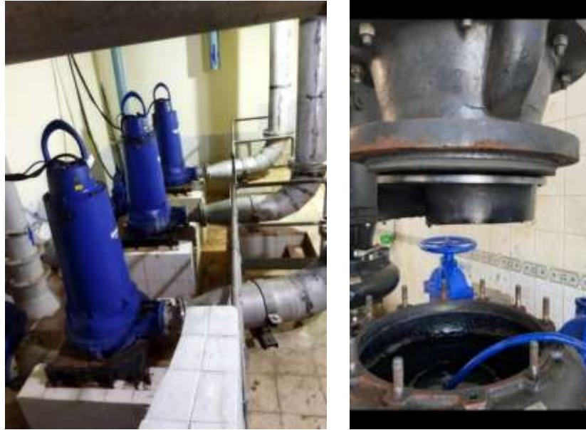
Şekil 3.2: Dalgıç Kuru Tip Terfi Pompa ve Fan Salyangoz Yapısı
