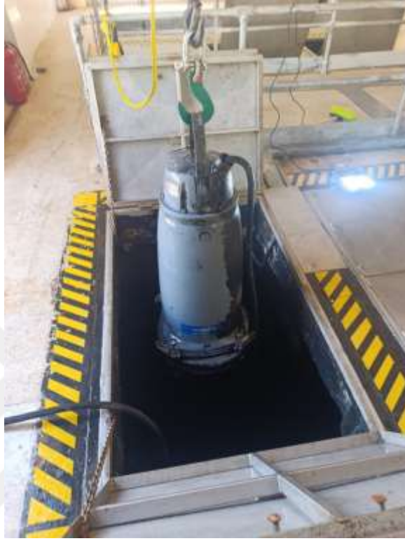
Şekil 3.1: Dalgıç ıslak Tip Terfi Pompası
