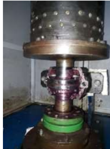
Şekil 3.3: Dikey Milli Tip Santrifüj Pompa Motoru ve Dikey Mil Yapısı
