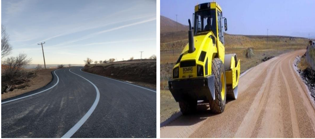
Şekil 3.9: Yol yapım çalışmalarına ait örnekler
