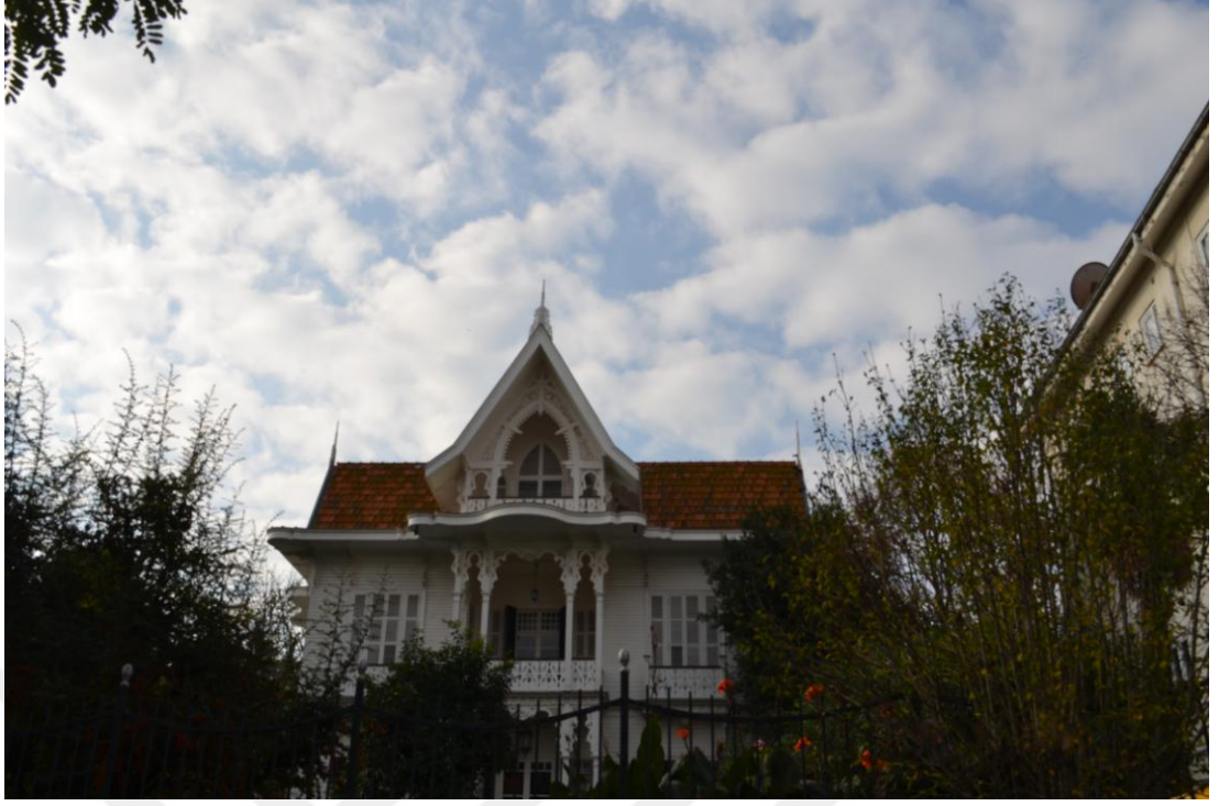
Şekil 3.9 : Yılmaztürk Caddesi üzerinde bulunan bahçeli üç katlı ahşap köşk.
