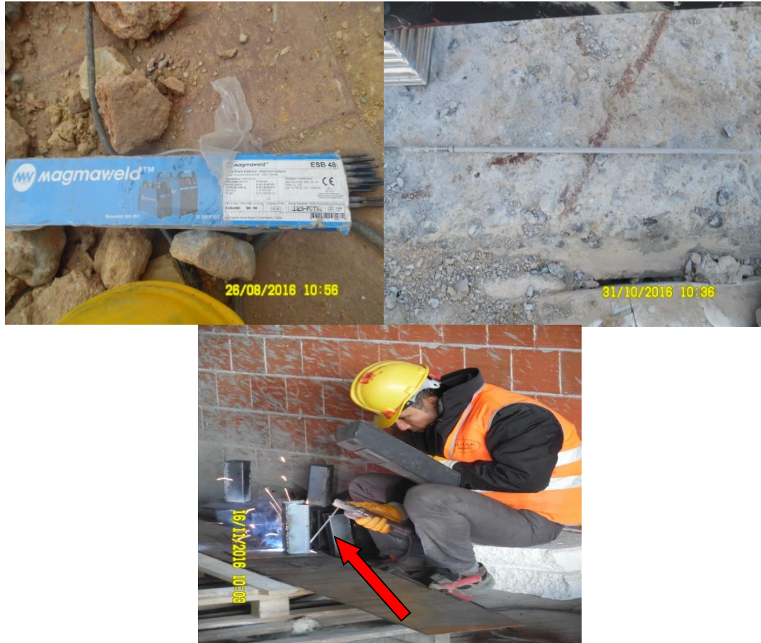
Resim 2.24. Çubuk elektrot
