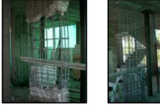
Şekil 6.14: Kolonlarda Hasarlı Bölgenin Çıkartılması
