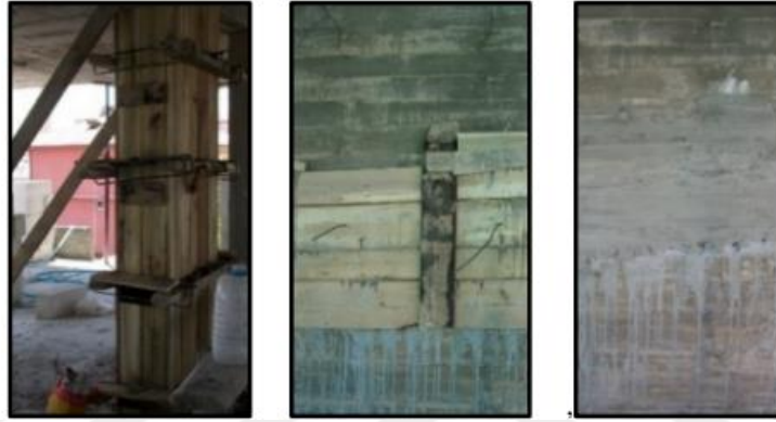
Şekil 6.15: Hasarlı Olan Bölgelerde Beton Kalıbı ve Beton Yerleştirilmesi
