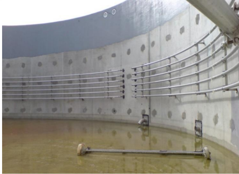
Şekil 2.9 : Dahili ısı eşanjörlü reaktör iç dizaynı
