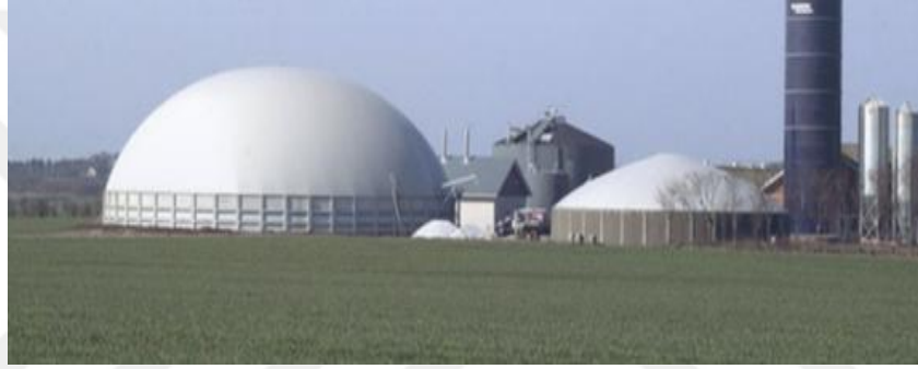
Şekil 2.8 : Balon tipi biyogaz tesisleri
