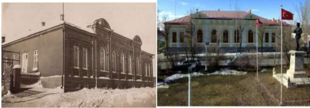
Şekil 16.25: Restore Edilmeden Önceki Vali Konağı ve Bugünkü Vali Konağı
