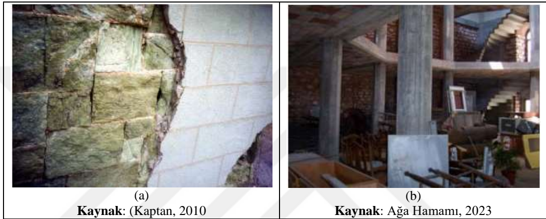
Şekil 8.4: a) Yanlış Malzeme Seçimi b) İşlev Değişikliği ve Yanlış Müdahale
