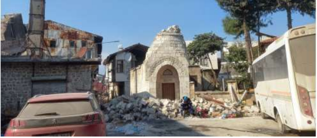
Şekil 21.3: Sarımiye Camii 6 Şubat Depremi Sonrası
