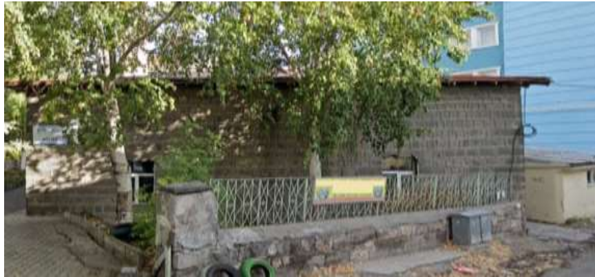
Şekil 16.39: Hacı Seyfi Camii
