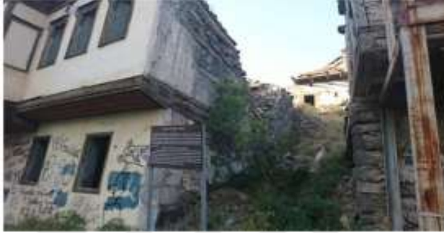
Şekil 15.2: Ahşap Hatılların Kullanıldığı Bina Örneği
