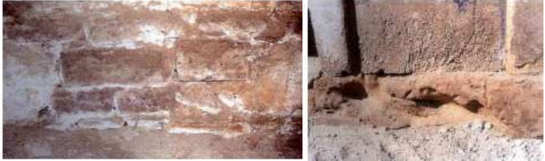
Şekil 8.3: Taşta Oluşan Tuzlanma Örneği ve Suyun Taşta Oluşturduğu Oyuklanma Örneği
