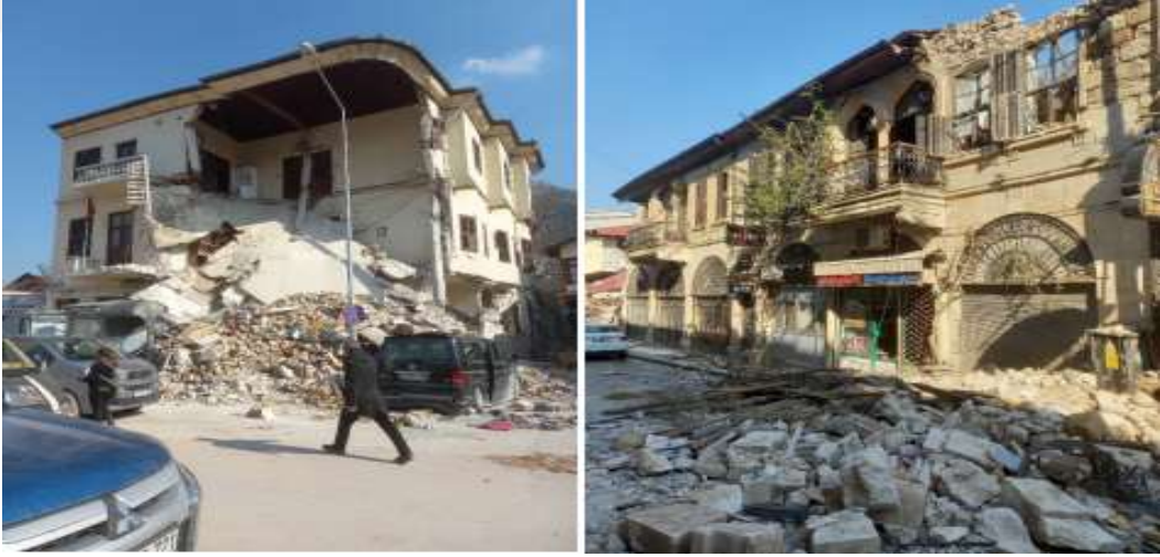
Şekil 21.4: Tarihi Kent Merkezindeki Sivil Mimarlık Örnekleri- Antakya
