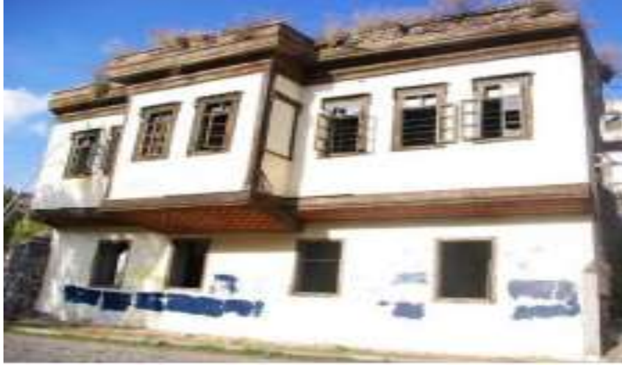
Şekil 15.3: Ahmet Tevfik Paşa Konağı, Kars İlindeki Osmanlı Konut Örneği
