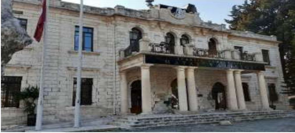
Şekil 21.1: Hatay Valilik Binası – 6 Şubat Depremi Sonrası
