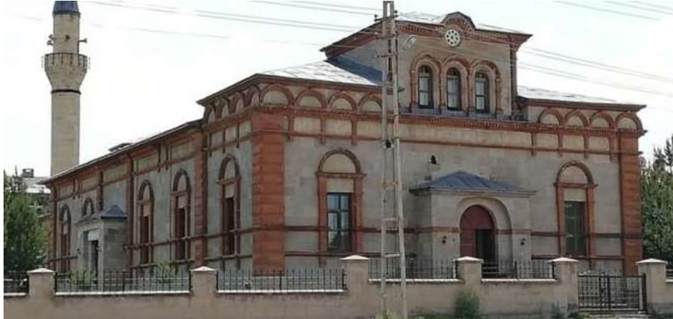
Şekil 16.76: Sarıkamış Kazım Karabekir Camii
