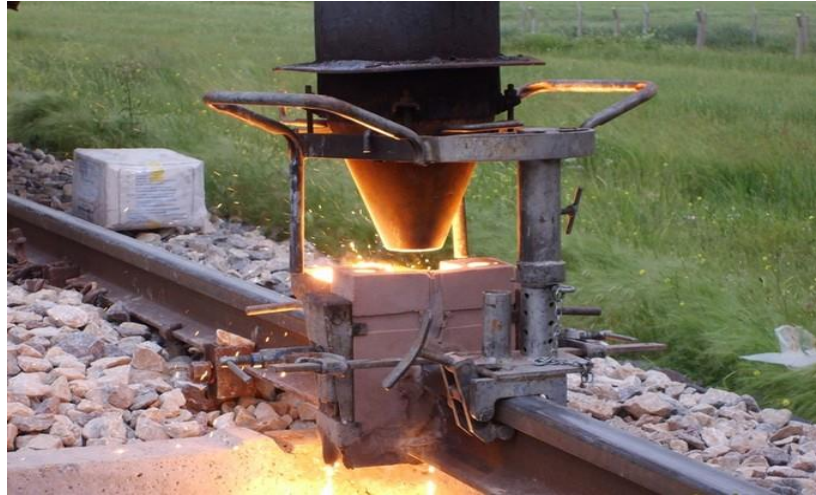
Şekil 4. 5: Demir Yolu Raylarının Termit Yöntemiyle Birleştirilmesi (URL-14, 2021)
