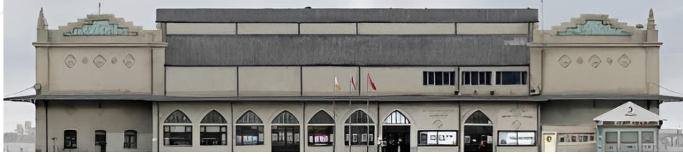
Şekil 4.13: Haldun Taner Tiyatro Binası, Doğu Cephesi
