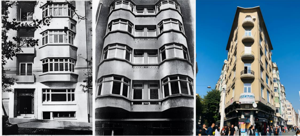
Şekil 2.31, 2.32, 2.33: Bosfor Apartmanı, Melek Apartmanı, Pertev Apartmanı
