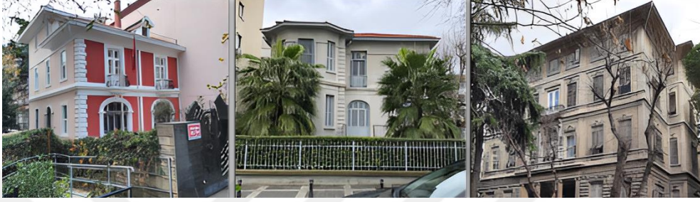
Şekil 3.20: Barış Manço Müzesi, Antipa Köşkü ve Arif Sarıca Köşkü
