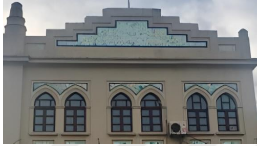
Şekil 4.12: Haldun Taner Tiyatro Binası, Kademelenme Biçimi
