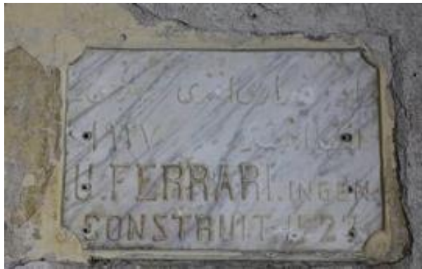
Şekil 4.8: Yapının Mimarı ve Yapım Yılı'nın Yazıldığı Kitabe
