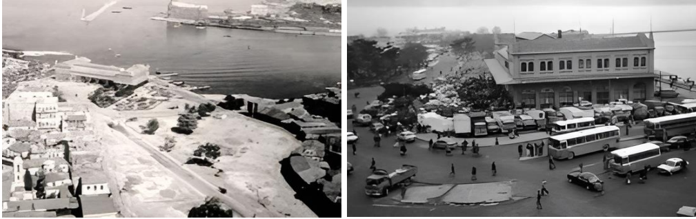
Şekil 4.6: İstimplaklarla Önü Açılan Hal Binası ve Çevresi
