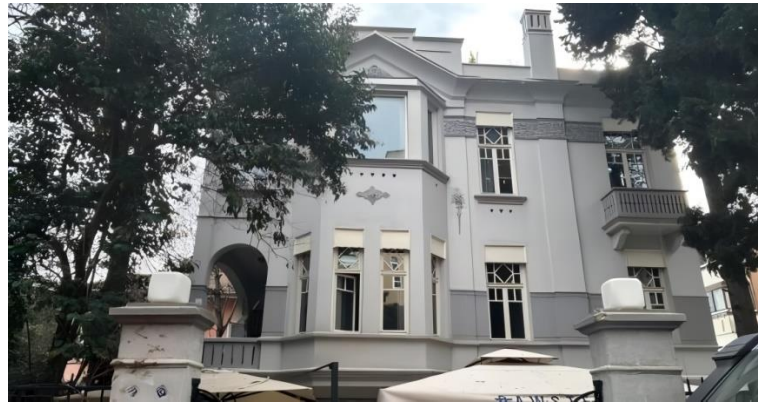
Şekil 4.89: Dr. Mahmut Ata Bey Köşkü, Kuzey Cephesi Detayları
