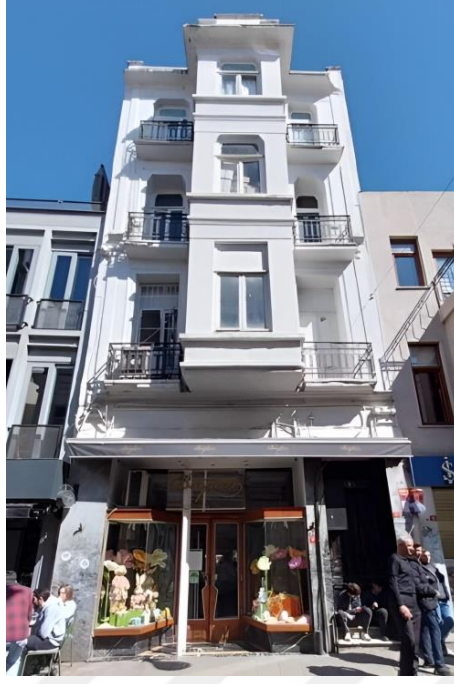
Şekil 4.96: Muvakkıthane Caddesi 9/A No'lu Yapı, Güney Cephesi
