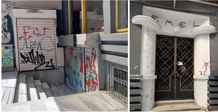
Şekil 4.68: Emel Apartmanı, Bodrum Kat Girişi ve Apartman Girişi
