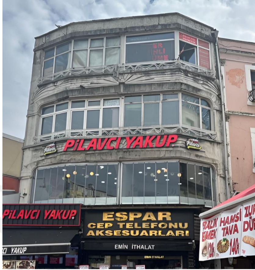
Şekil 4.116: Söğütlüçeşme Caddesi 26 No'lu Yapı, Cephe Detayları
