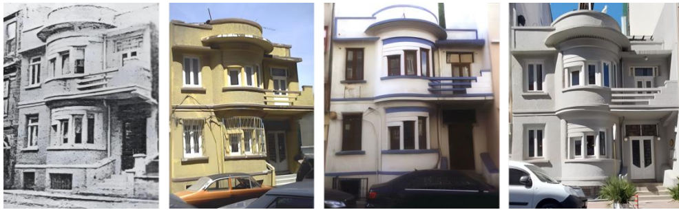
Şekil 4.34: Yıllar içinde Mühürdar Caddesi 78 No'lu Yapı'nın Değişimi
