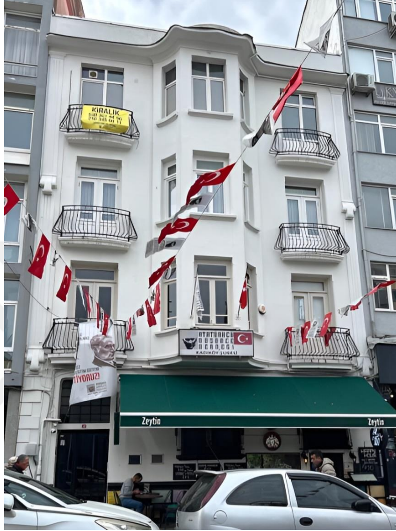
Şekil 4.42: Moda Caddesi 30 No'lu Yapı, Doğu Cephesi
