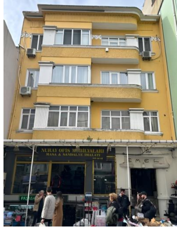
Şekil 4.65: Emel Apartmanı, Doğu Cephesi
