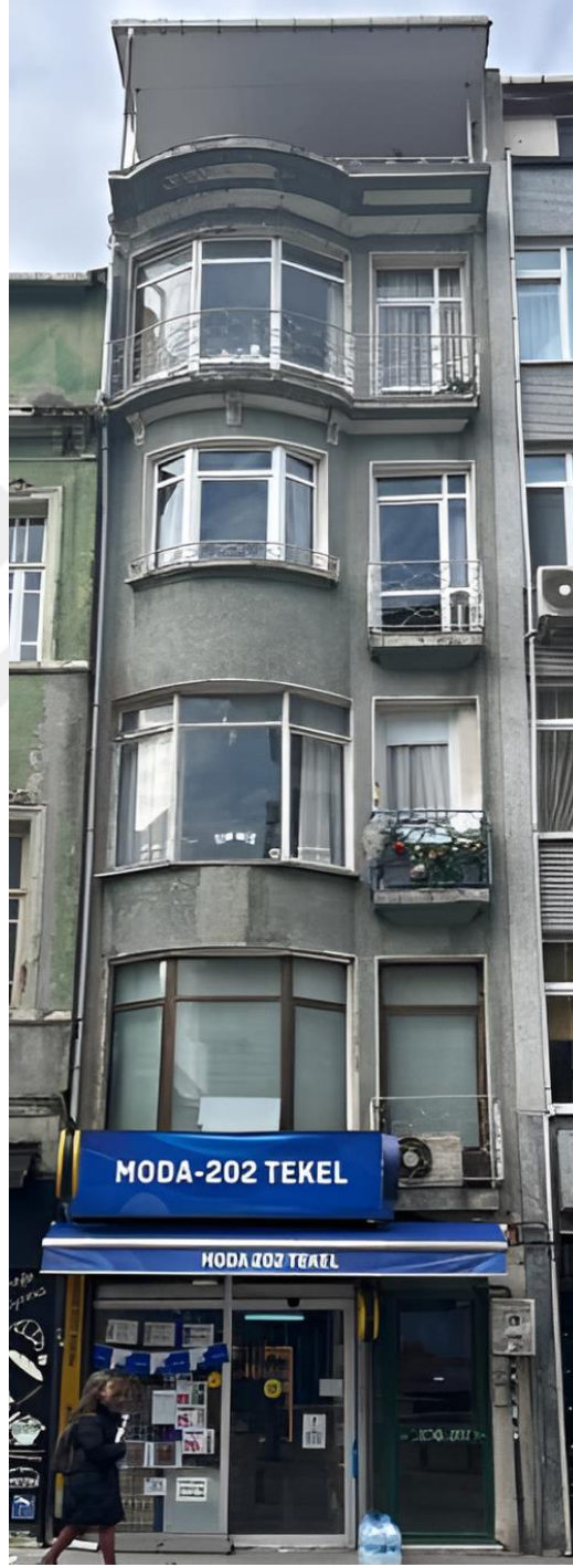
Şekil 4.54: Moda Caddesi 126 No'lu Yapı, Doğu Cephesi
