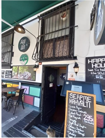
Şekil 4.40: Moda Caddesi 30 No'lu Yapı, Mevcut Bodrum Kat Girişi
