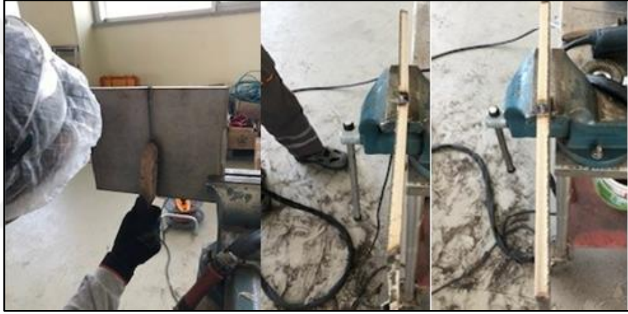
Şekil 5.6: Kaynak İşlemi Esnasında Sırasıyla Fırça İle Temizle, Sulama Öncesi ve Sonrası Durum
