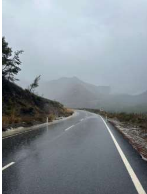
Şekil 4.4: Muğla / Marmaris /Adaköy Mahallesi DKK Aksaz Deniz Üssü Yolu 04.01.2025 14:39 Sonrası
