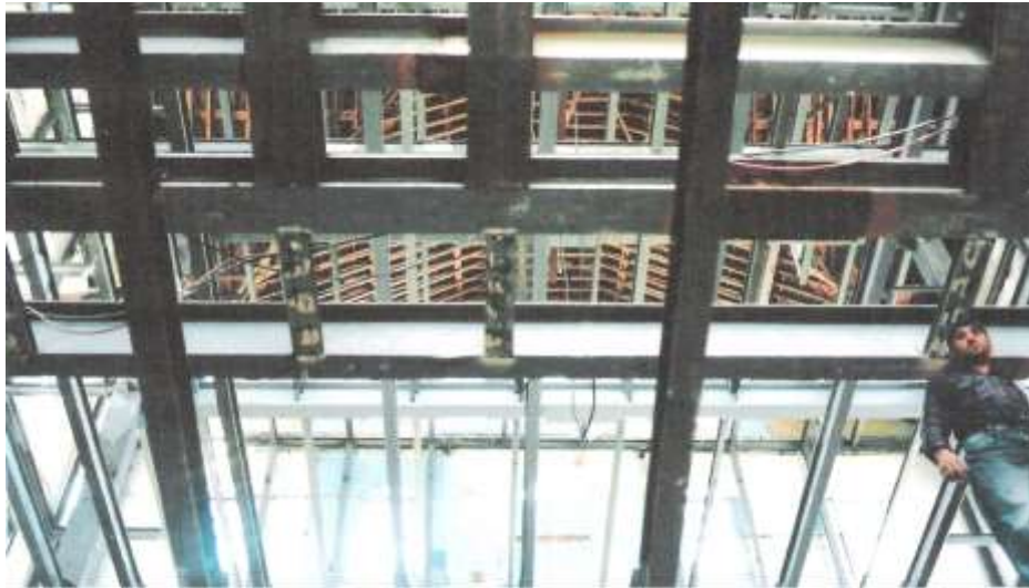
Şekil 4.48: Sticker Hall Çatı Kaplaması Sökümü Sonrası Fotoğrafı
