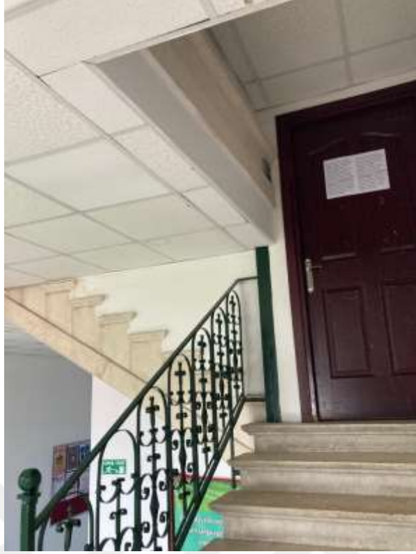
Şekil 4.71: Stickler Hall Çatı Katına Çıkış Merdiveni Fotoğrafi
