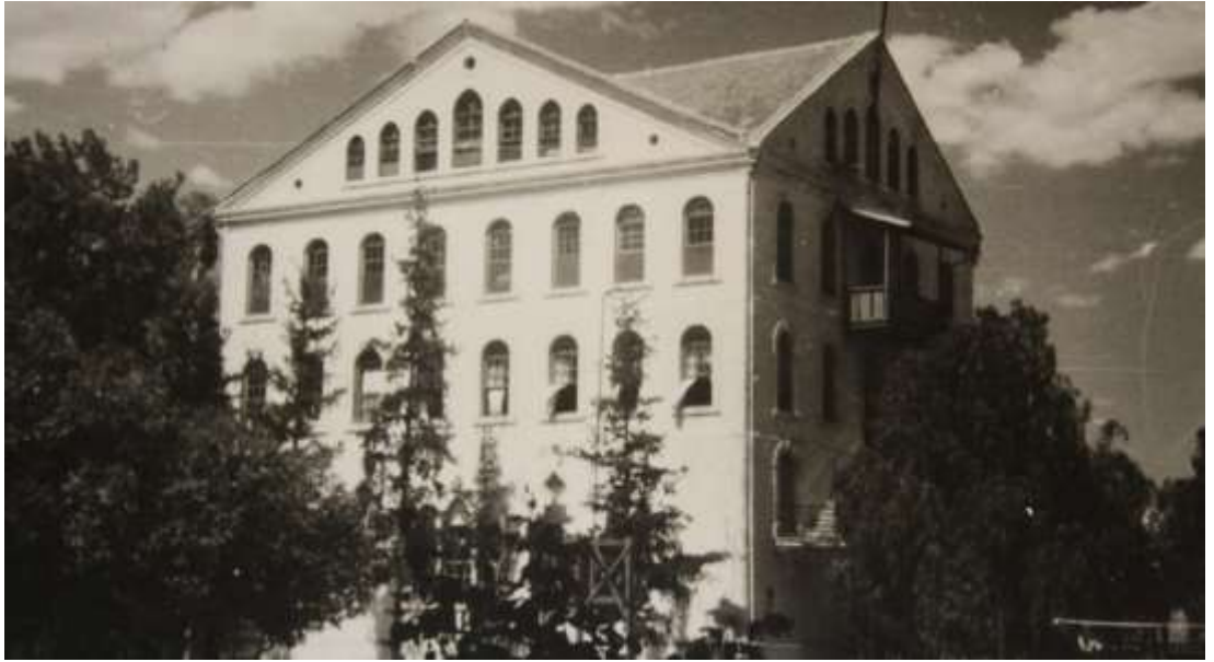
Şekil 4.19: Stickler Hall Güneybatı Cephe Restorasyon Öncesi Fotoğrafi
