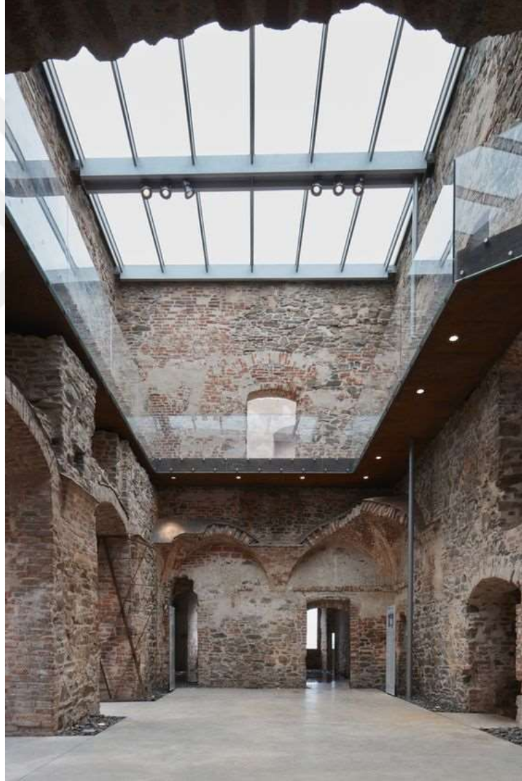
Şekil 4.67: Helfstyn Kalesi Restorasyon Sonrası Fotoğrafı
