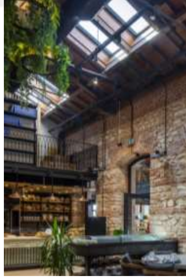
Şekil 4.61: Fişekhane Restorasyon Sırasında Eklenen Asma Kat Fotoğrafi
