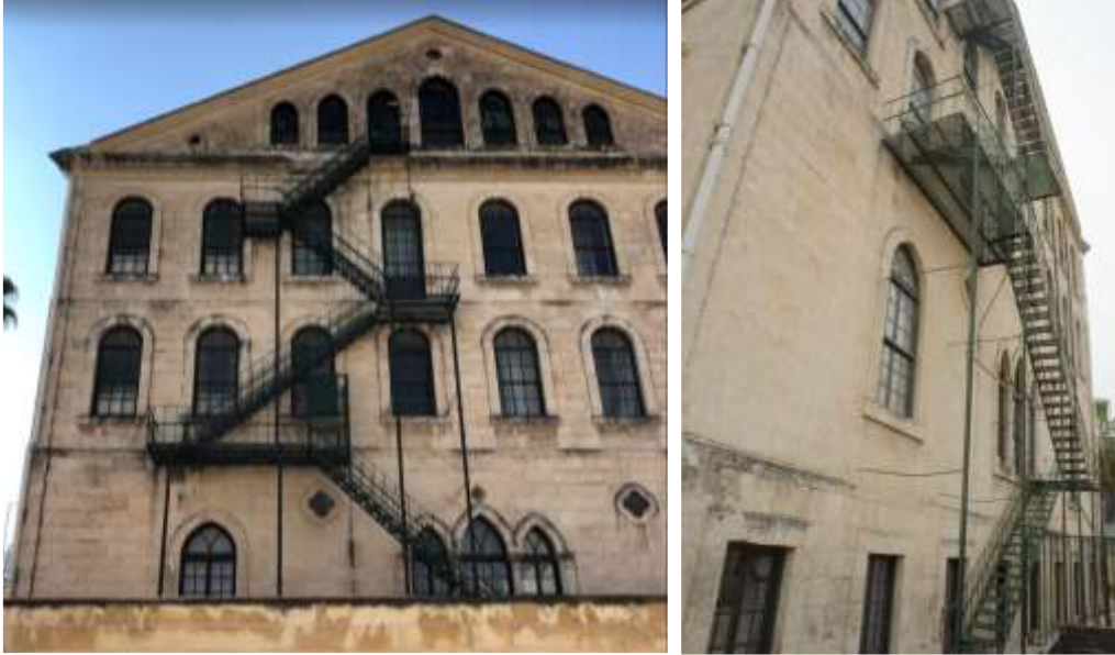
Şekil 4.22: Kuzeydoğu Cephesi Restorasyon Sonrası Fotoğrafları
