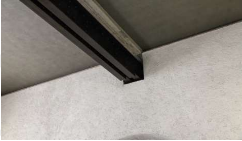
Şekil 2.5: Castelvecchio Müzesi, Kiriş ve Duvar Birleşim Detayı
