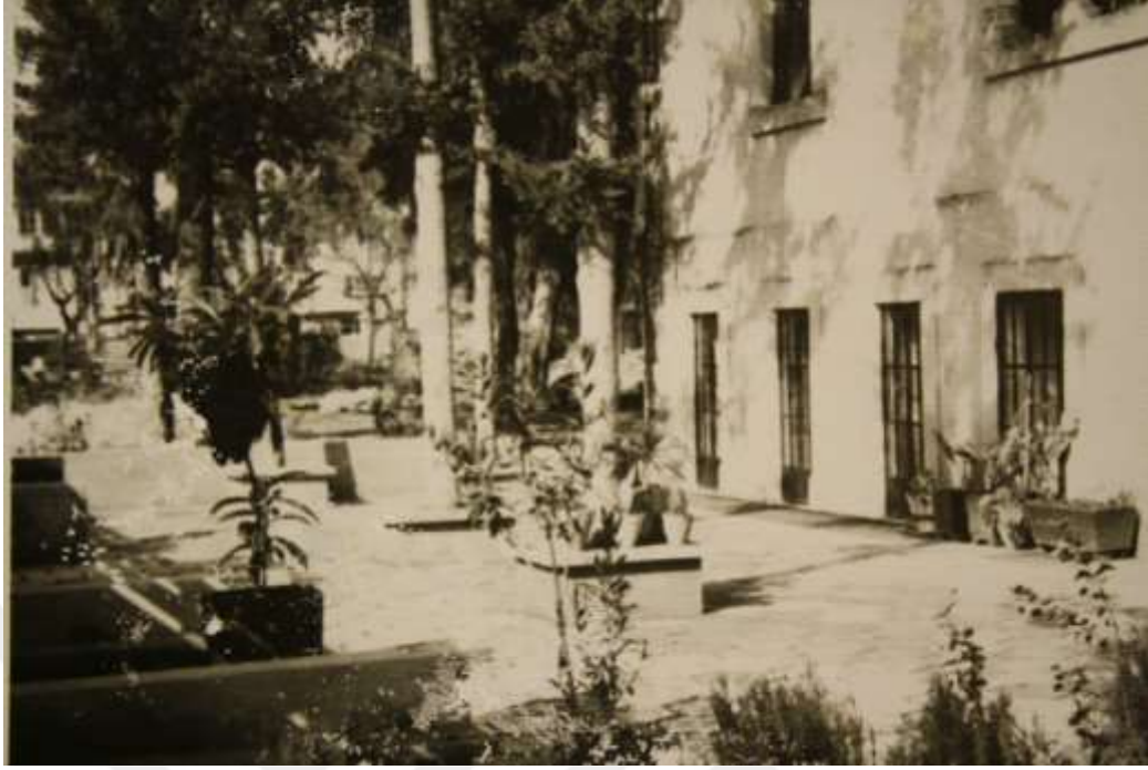
Şekil 4.17: Stickler Hall Güneybatı Cephesi Restorasyon Öncesi Taş Avlu Fotoğrafi
