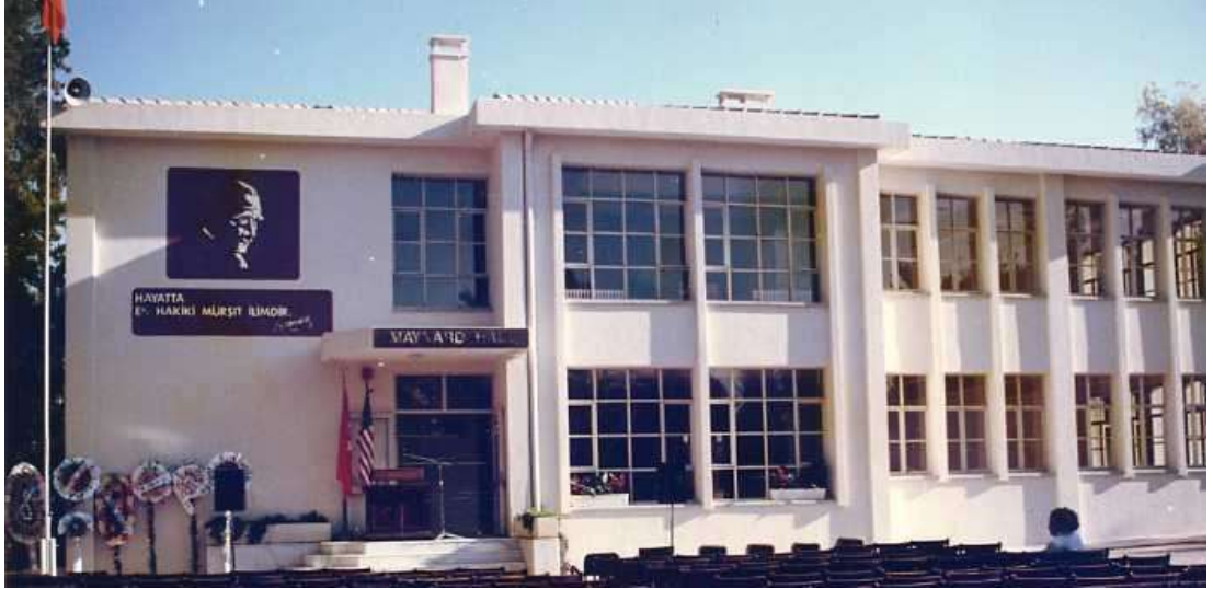
Şekil 4.8: Maynard Hall Binası Giriş Cephesi Fotoğrafi
