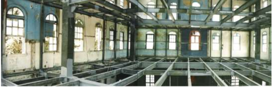
Şekil 4.49: Stickler Hall Restorasyon Sürecinde İkinci ve Üçüncü Kat Çelik Karkas Döşeme Fotoğrafi
