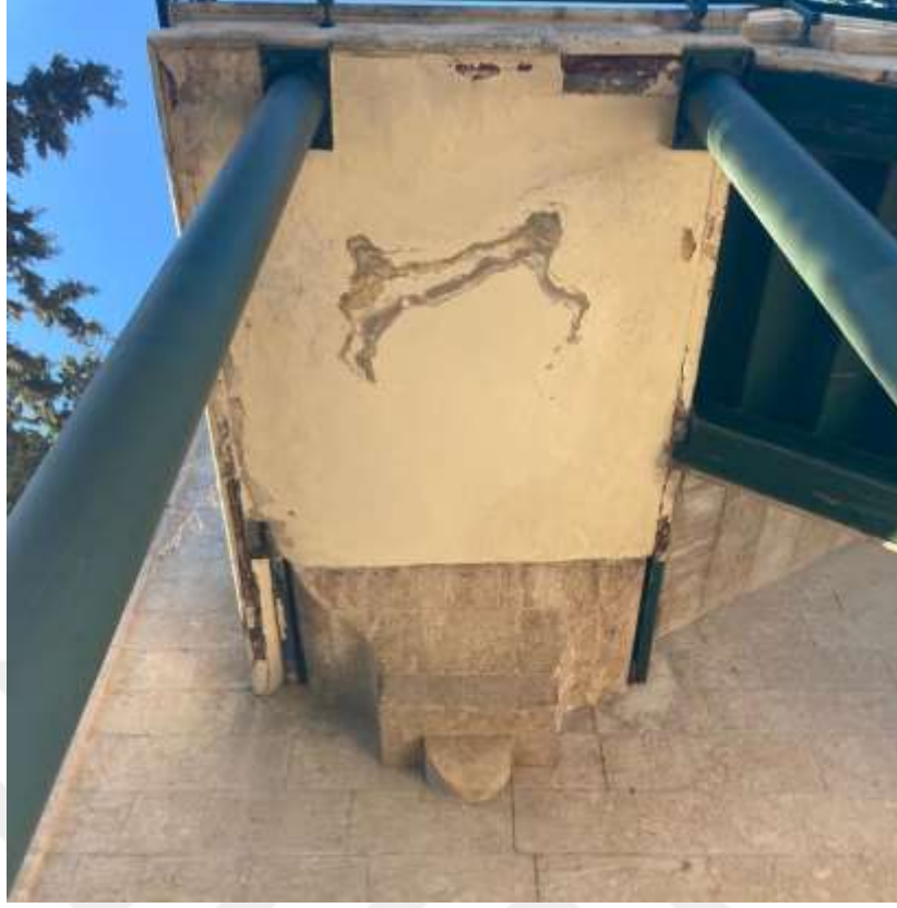
Şekil 4.75: Stickler Hall Giriş Cephesi Merdiven Konstrüksiyonu Duvar Birleşim Fotoğrafi
