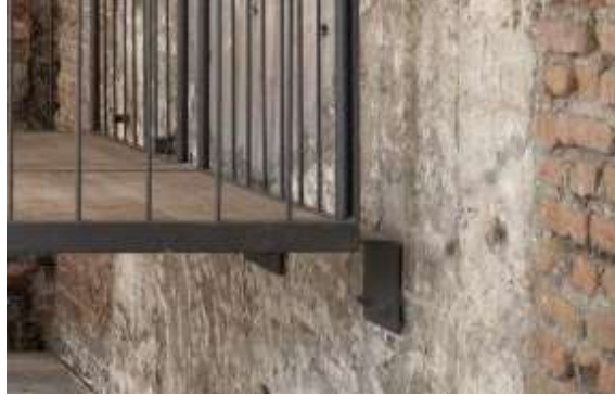
Şekil 4.76: Bomonti Bira Fabrikası Restorasyonu Merdiven Duvar Birleşim Fotoğrafi
