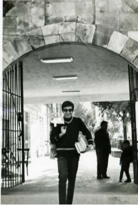
Şekil 4.36: Kampüs Ana Giriş Kapısı Restorasyon Öncesi Fotoğrafı
