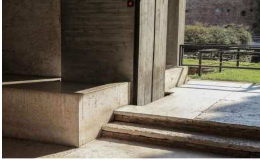
Şekil 2.7: Castelvecchio Müzesi, Duvar ve Zemin Birleşim Detayı
