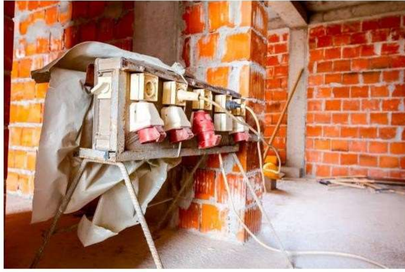
Şekil 6.15: Uygun Olmayan Pana Örneği
