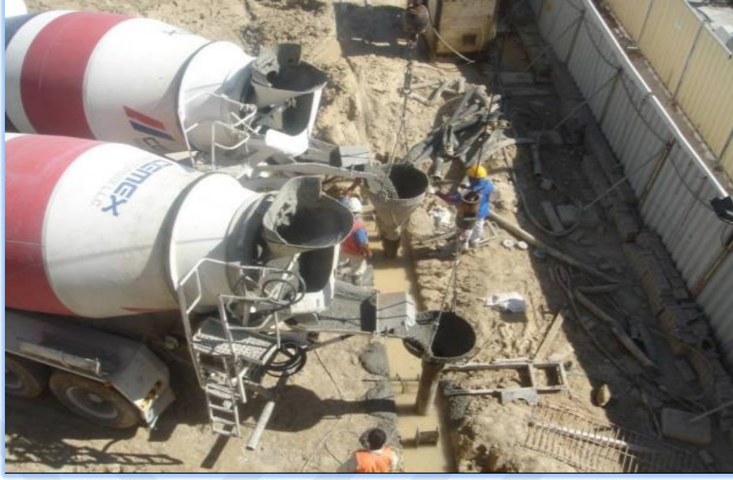
Şekil 2. 26: Beton Döküm İşlemi - Diyafram Duvar
