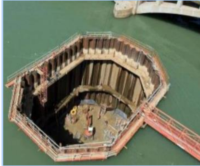
Şekil 2. 38: Batardo - Çelik Palplanş Perde
