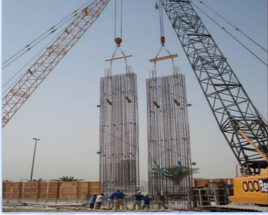
Şekil 2. 25: Donatıların Yerleştirilmesi -Diyafraam Duvar
