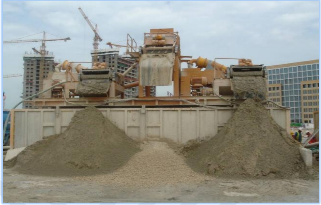
Şekil 2. 24: Panellerin Kumdan Arındırılması - Diyafram Duvar
