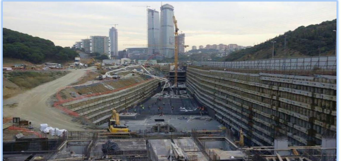
Şekil 2. 4: Vadipark Seyrantepe Rezidans İksa Projesi - Dünya Zemin
