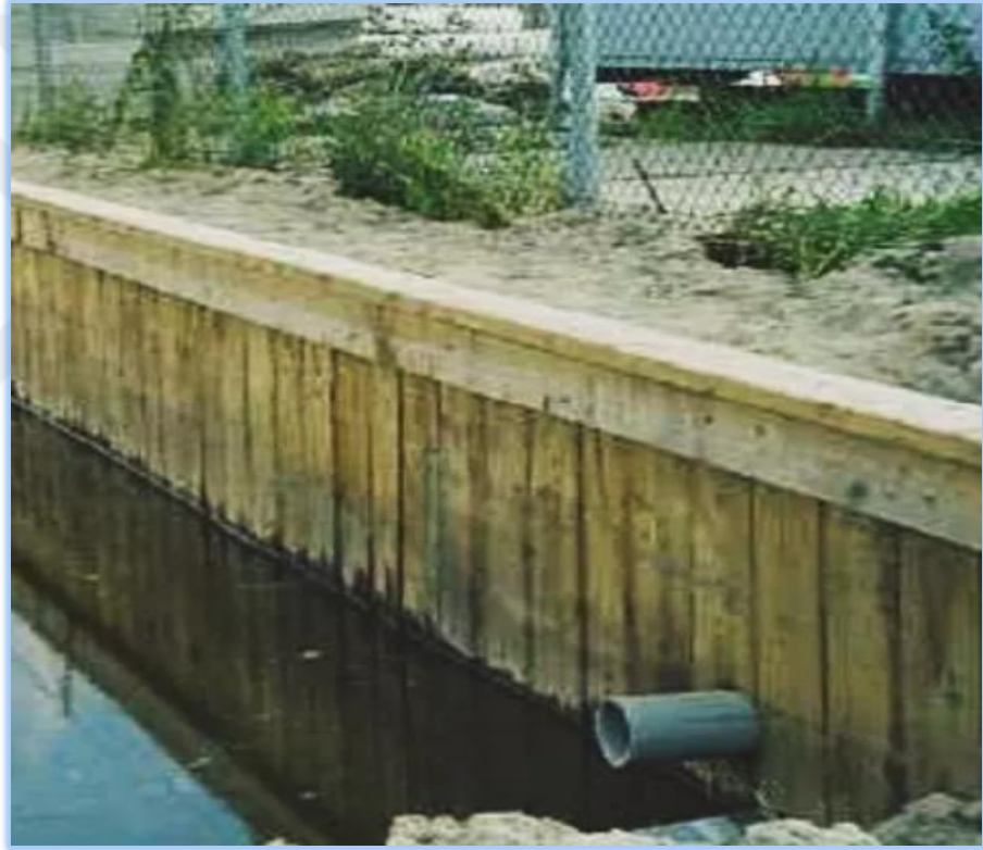
Şekil 2. 41: Uygulama Örneği - Ahşap Palplanş Perde
