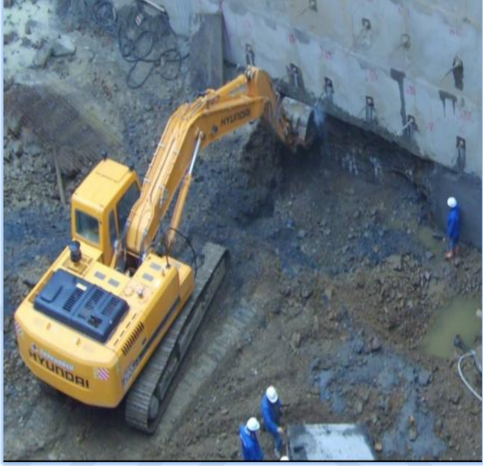
Şekil 2. 33: İş Makinasının Perde İçin Kazı Çalışması - Perde Duvar
