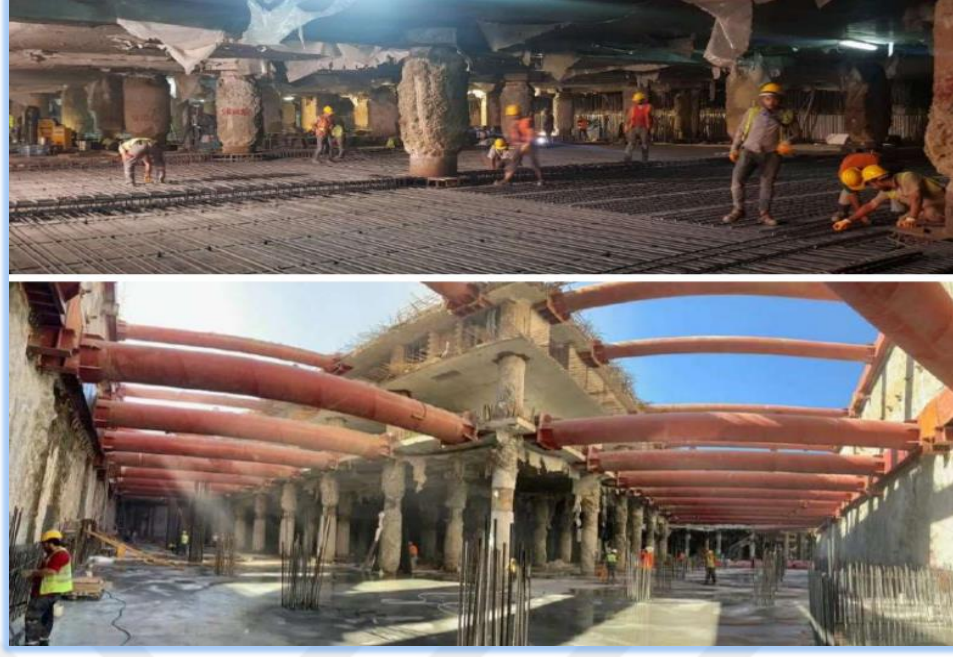
Şekil 2. 45: Yukardan - Aşağıya Kazı Destekleme Sistemi - Şantiye Aşaması
