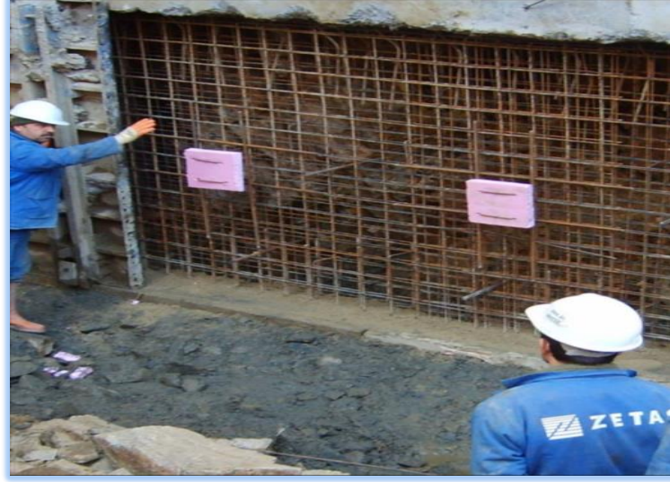
Şekil 2. 34: Panele Strafor Uygulaması Ankraj İçin Yer Açılıyor - Perde Duvar, Zetaş
