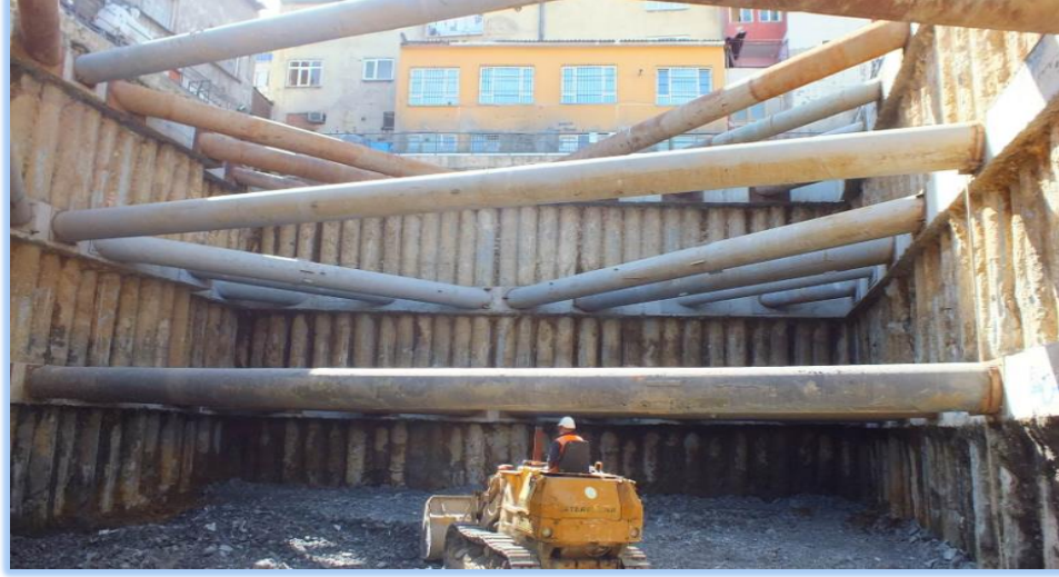
Şekil 2. 32: Boru Destek Uygulama Örneği - Kasımpaşa Pi House Rezidans İksa Projesi, Dünya Zemin
