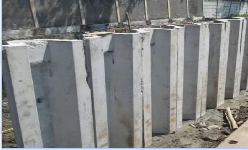
Şekil 2. 39: Betonarme Palplanş Perde
