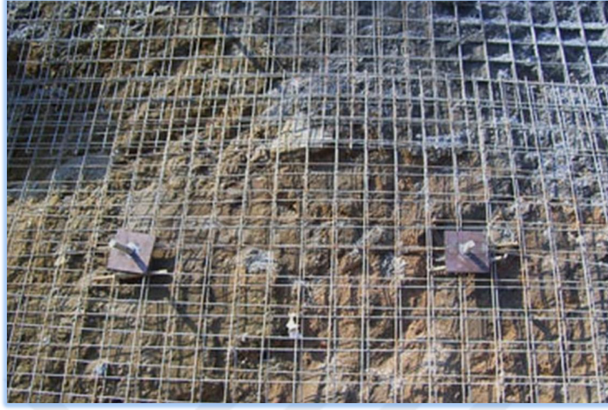
Şekil 2. 37: Başlıkların Püskürtme Beton ile Çelik Hasırlara Tuturulması
