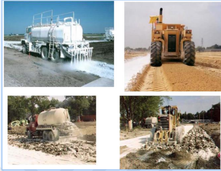
Şekil 2. 2: Zeminlerin Kimyasal Stabilizasyonuna örnek - Kireçle Stabilizasyon.
