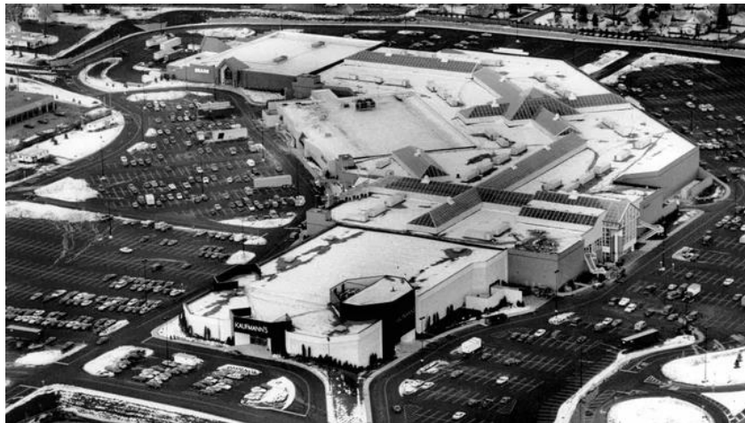
Şekil 4.46: Irondequoit Alışveriş Merkezi, 1990
