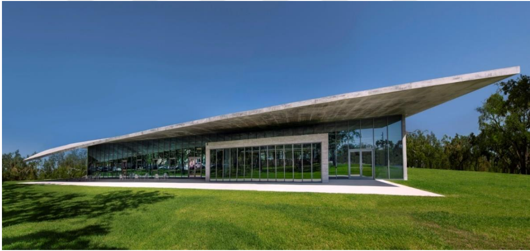
Şekil 2.8: Miami Üniversitesi Mimarlık Fakültesi Thomas P. Murphy Tasarım Stüdyosu Örneği – Eğimli Çatı
