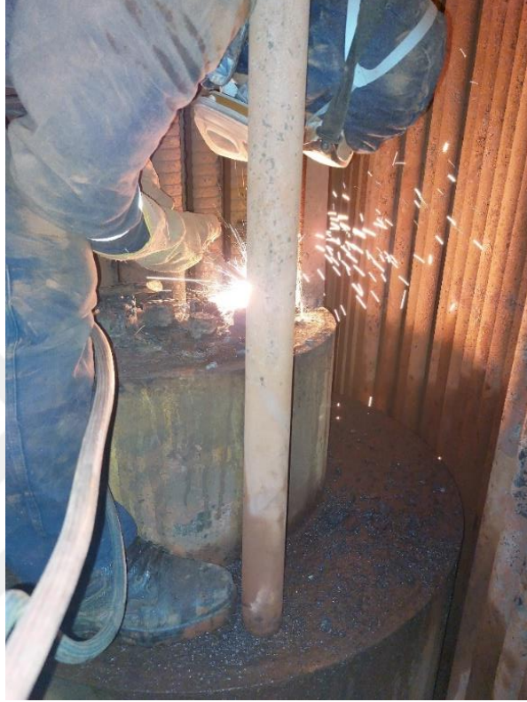
Şekil 6.3: Uygulama alanı buhar kazanı boru tamirat ve kaynak işlemi
