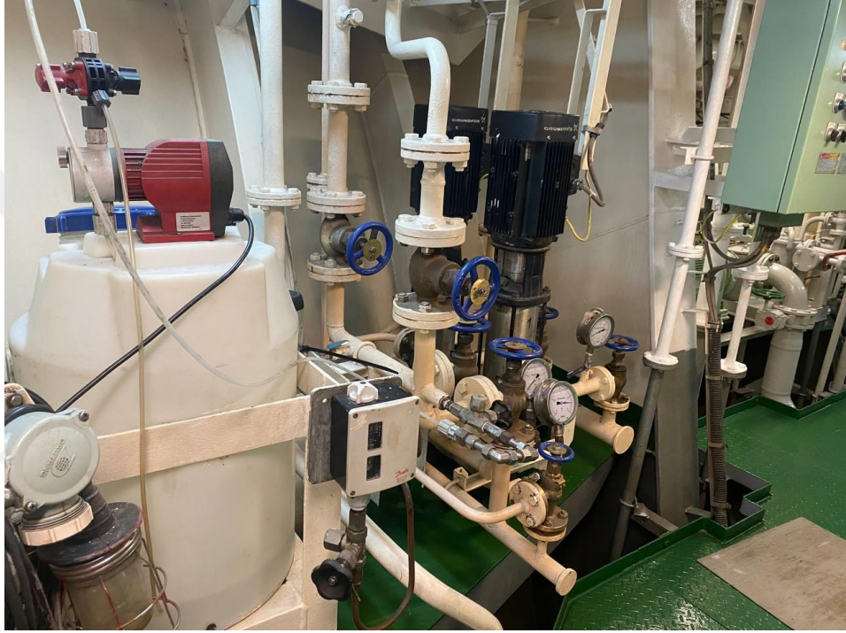
Őekil 6.8: Besi suyu kimyasal dozajlama őritesi
