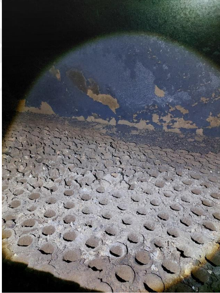
Şekil 6.4: Kazan Boruları üzerinde biriken kurum ve küller
