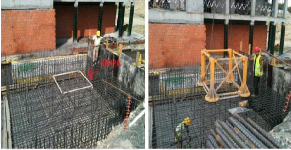
Şekil 17: Kule Vinç Kurulumu (ADV, 2015).
