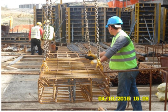
Şekil 24: İşaretçinin Kule Vinç Operatörünü Telsiz İle Yönlendirmesi.
