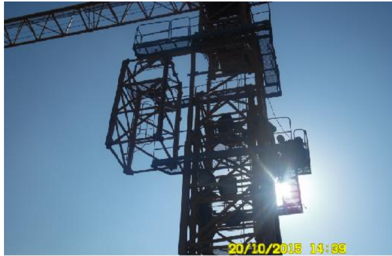
Şekil 21: Kule Vinç Gövde Yükseltme Çalışması.
