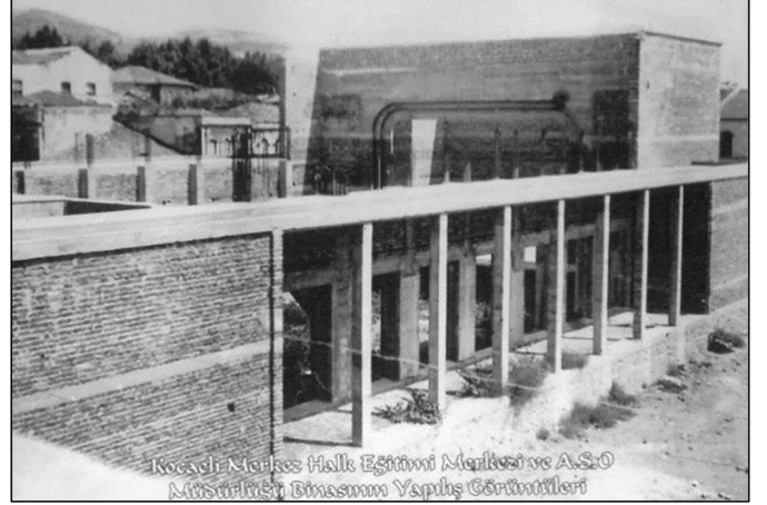
Resim 9. İzmit Halkevi Binasının Yapımı (Url-1).
