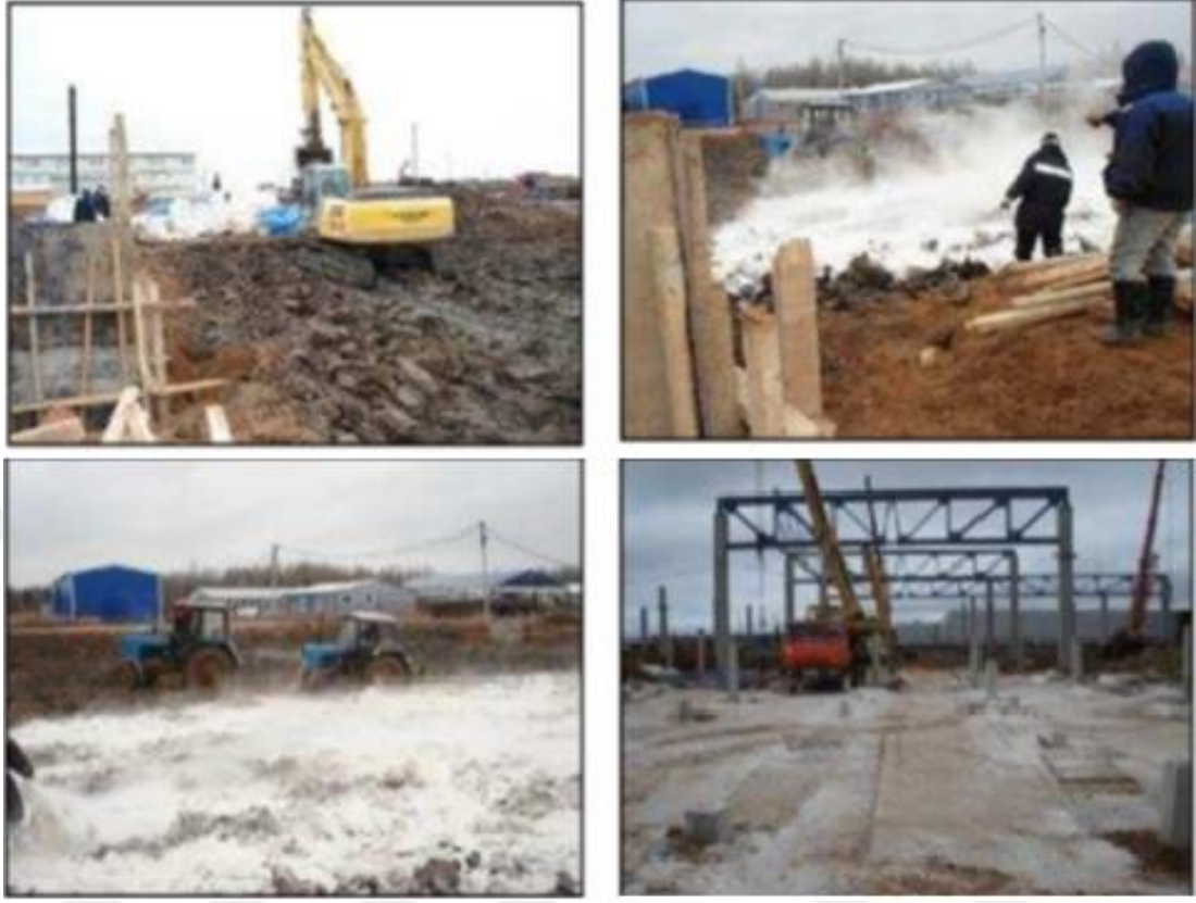
Şekil 1.4: Kireç ile Zemin İyileştirme Aşamaları
