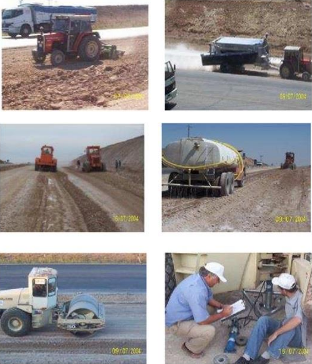
Şekil 1.5: Karayolunda Kireç ile Zemin İyileştirme
