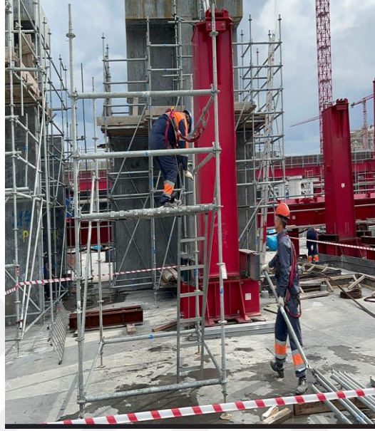
Şekil 4.9: Boru Kelepçelerinin Montajı
