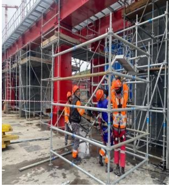
Şekil 4.3: İskele Merdiven Sisteminin Montajı
