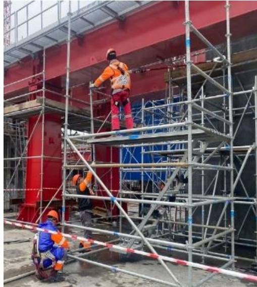
Şekil 4.5: İskele Korkuluklarının Montajı
