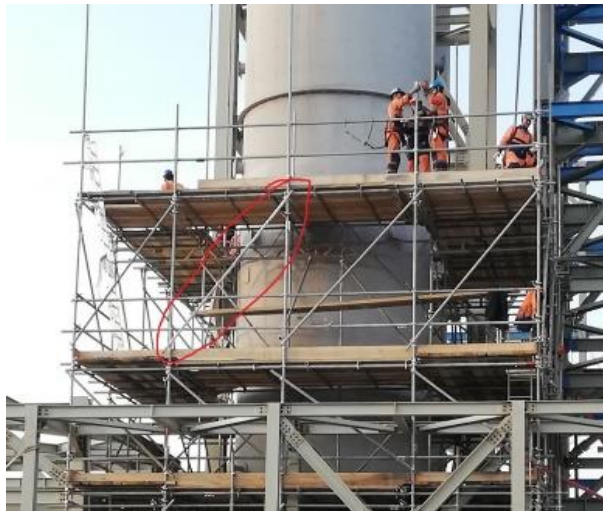
Şekil 4.7: Çapraz Bağlantıların Montajı
