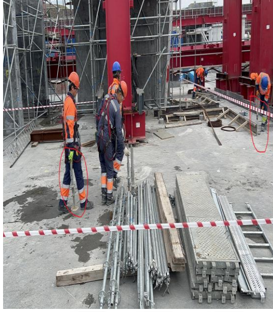
Şekil 4.8: Taban Plakalarının Montajı
