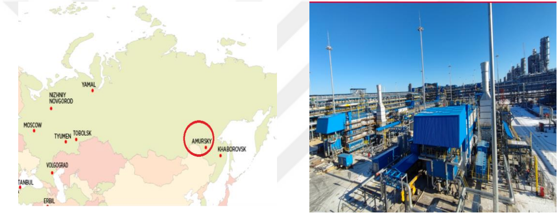
Şekil 4.1: Gaz İşleme Tesisi P2 ve Amursky TF Görünümü
