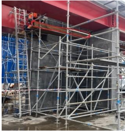
Şekil 4.6: Topuk Levhasının (Süpürgelik) Montajı
