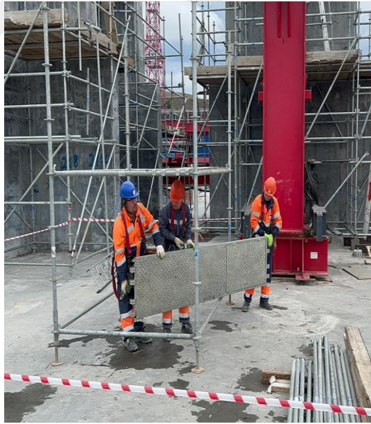
Şekil 4.4: İskele Çalışma Platformunun Montajı
