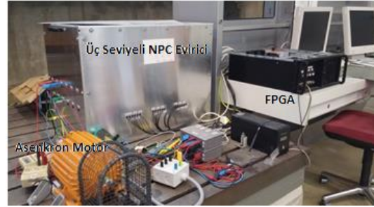
Şekil 8. Üç seviyeli NPC evirici ile sürülen asenkron motor test düzeneği
