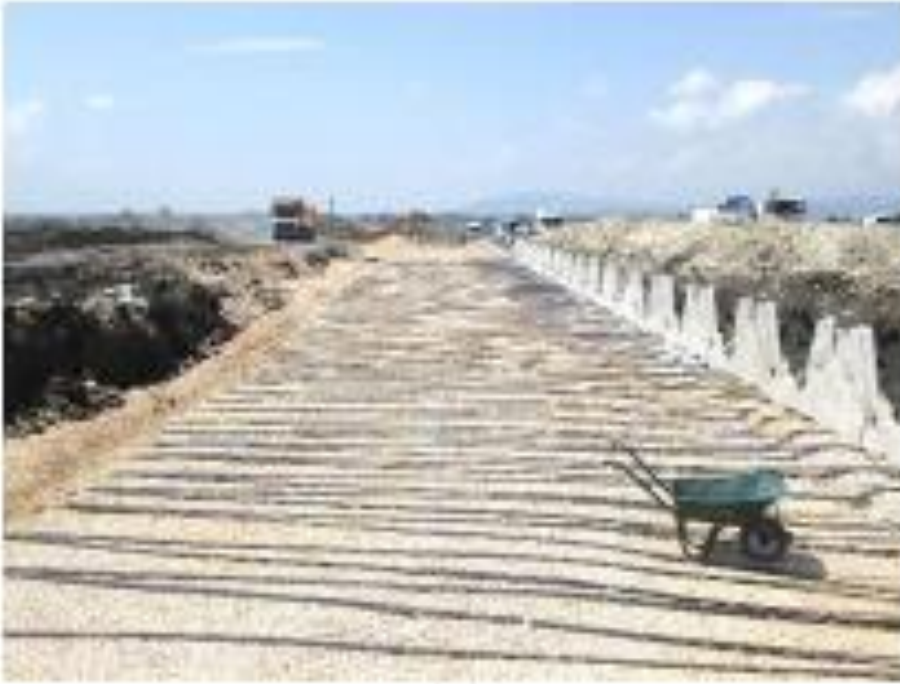
Şekil 2.8 : Gölkıy köprülü kavşağı (Evirgen, Kelek, Acarca ve Tuncan, 2019).
