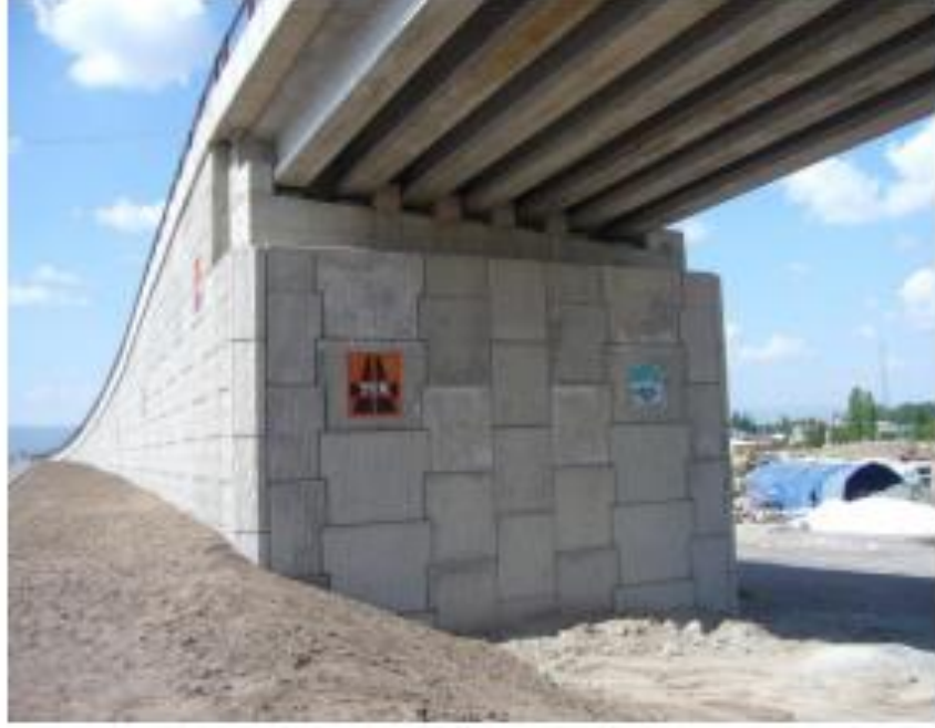
Şekil 2.11 : Toprakarme yapıya köprü örneği (Yılmaz, 2019).
