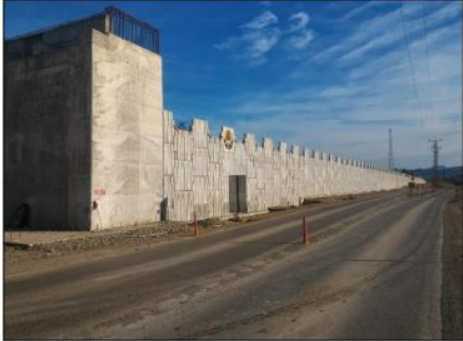
Şekil 2.4 : Bartın'da bulunan şerit donatılı toprakarme yapısı (Yılmaz, 2018)
