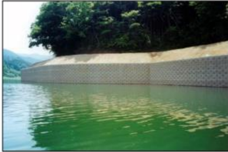
Şekil 2.10 : Toprakarme yapıya sulu alan örneği (Yılmaz, 2018).
