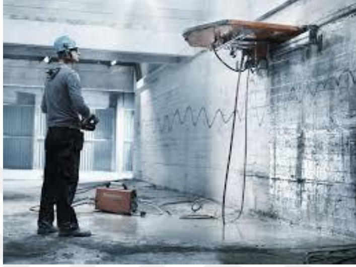
Şekil 2.2 : Raylı (Hidrolik) beton kesme uygulaması (www.karot.org).
