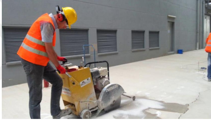
Şekil 2.3 : Yer (Derz) kesme uygulaması (www.karot.org).
