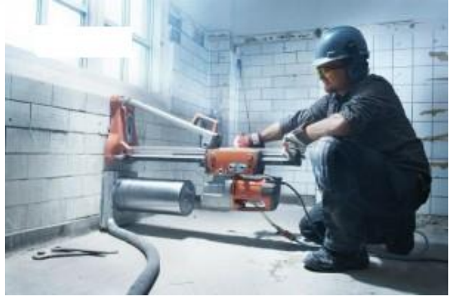
Şekil 2.1 : Beton delme (karot) makinası ve beton delme uygulaması (www.karot.org).
