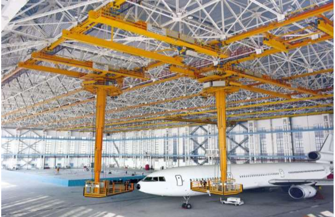
Şekil 6.6: Hangar Erişim Sistemleri: Teleskobik Platform
