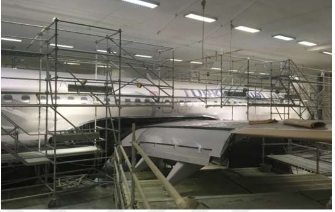
Şekil 6.7: Hangar Erişim Sistemleri: İskele
