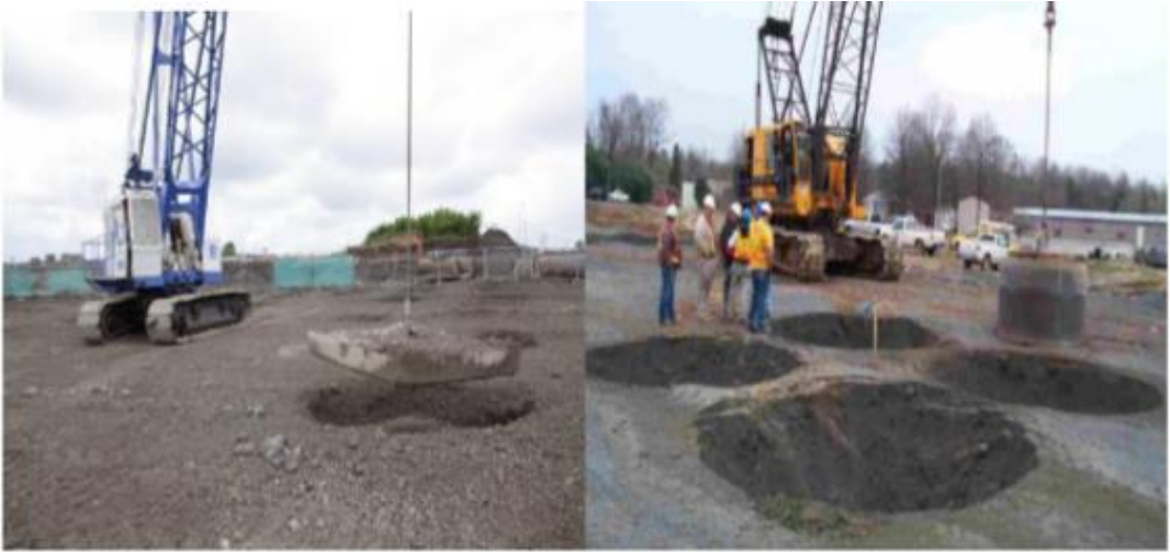
Şekil 2.8 : Tipik uygulama 15-20 ton ağırlık ve 15-20 metre düşme (Çınar, 2014).
