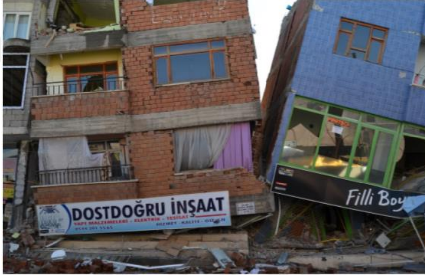
Şekil 2.2 : Erciş yerleşiminde 23 Ekim 2011 tarihinde gerçekleşen deprem sonrası sıvılaşmanın neden olduğu hasarın görüntüsü (Ak, 2019).
