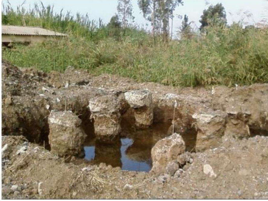
Şekil 2.30 : Fethiye' de kumlu silt birimlerde oluşturulmuş deneme kolonları (Gökalp & Düzceer, 2002).
