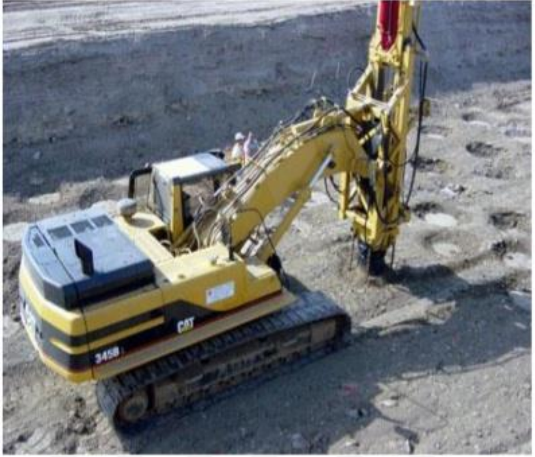
Şekil 2.7 : Hızlı darbeli sıkıştırma işlemi (Gül, 2015).
