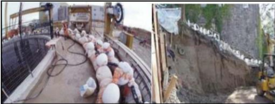
Şekil 2.11 : Zorlu bir eğimde tünel shaftının dondurularak kontrol altına alınması (Ercan, 2017).
