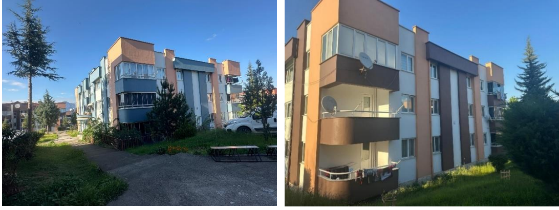
Şekil 5.18: Toplu Konut 1’de Binalar Arasında Yeterli Mesafe Olmadığı İçin Birbiri Üzerine Düşen Gölgeden Kaynaklı Aydınlanma Sorunu
