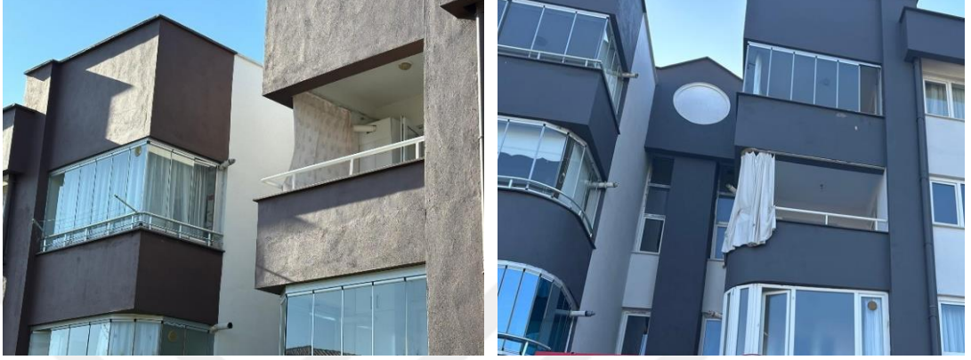
Şekil 5.40: Toplu Konut 1’de Birbirine Bakan Balkon Cephelerinin Perde veya Pencere ile Kapatılması
