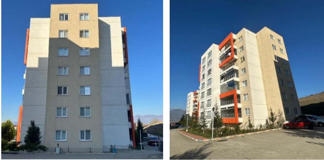
Şekil 5.22: Toplu Konut 2 Binalar Arası Yeterli Mesafenin Sağlanmamasından Dolayı Binaların Birbirini Gölgeleme Durumu
