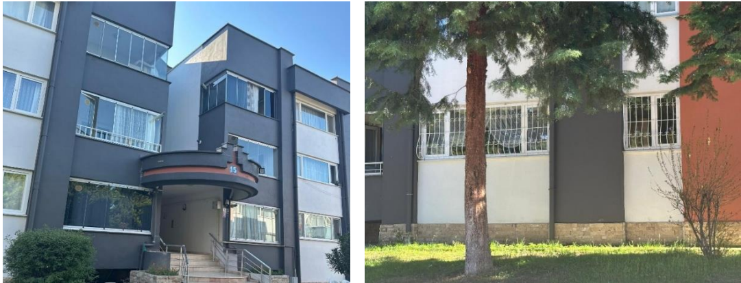
Şekil 5.35: Toplu Konut 1 Balkonların Güvenlik Amaçlı Kapatılması (Solda) ve Zemin Katlarda Pencere Korkuluklarının Kullanılması (Sağda)
