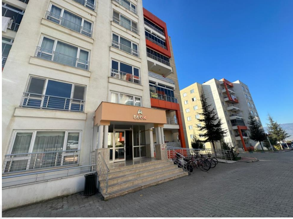
Şekil 5.38: Toplu Konut 2 Fransız Pencere Korkuluklarının Kullanılması ve Pencere Açılır Kanatlarının Parapet Mesafesinden Başlaması
