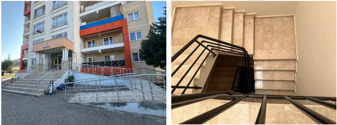
Şekil 5.15: Toplu Konut 2 Bina Giriş Rampası ve Ana Merdivenden Görünüş Kaynak: (Yazar, 2025)
