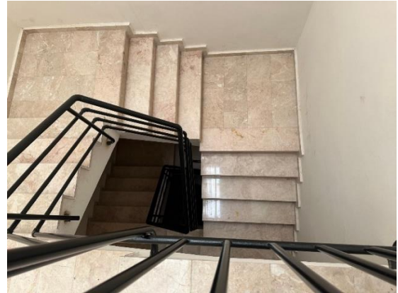
Şekil 5.39: Toplu Konut 2 Sitesinde Solda Giriş Merdiveninde Kaymayı Önleyici Önlem ve Sağda Ana Merdiven Kovanındaki Güvenlik Problemi
