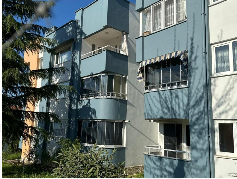
Şekil 5.27: Toplu Konut 1’de aşırı ısınmayı önlemek için alınmış önlemlerden Balkonların Sabit veya Açılır Toplanır Pencereyle Kapatılması, Pergolayla Kapatılması ve Perde Kullanılması
