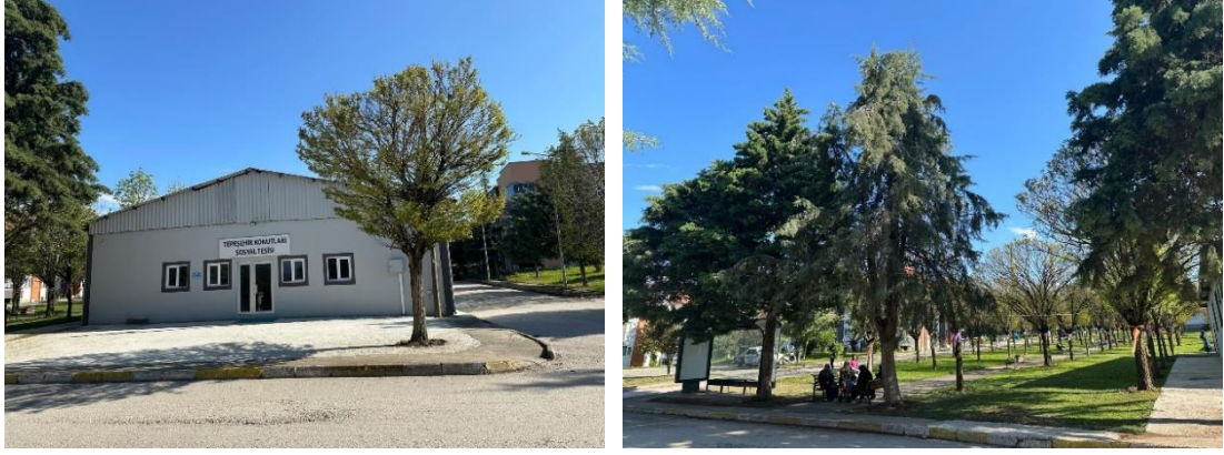
Şekil 5.44: Toplu Konut 1’de Sosyal Tesis ve Yanındaki Açık Alan Kullanımı Kaynak: (Yazar, 2025)
