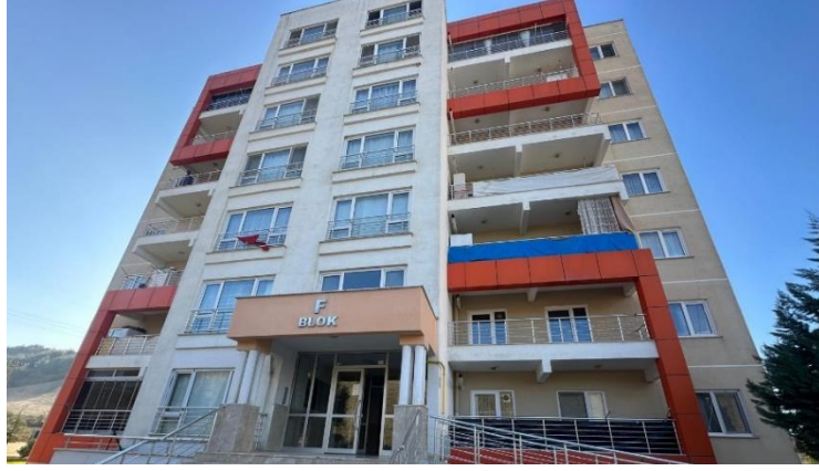
Şekil 5.41: Toplu Konut 2’de Balkon Korkuluklarının Örtülerle Kapatılması Kaynak: (Yazar, 2025)
