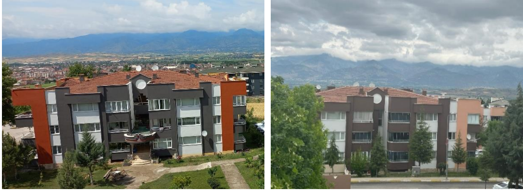
Şekil 5.12: Toplu Konut 1 (Tepeshir Konutları) Çatı Malzemesi
