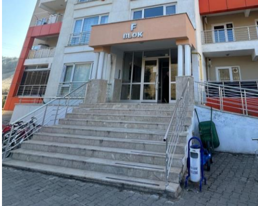
Şekil 5.39: Toplu Konut 2 Sitesinde Solda Giriş Merdiveninde Kaymayı Önleyici Önlem ve Sağda Ana Merdiven Kovanındaki Güvenlik Problemi
