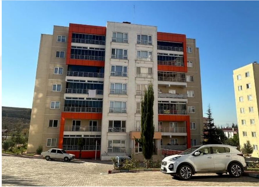
Şekil 5.31: Toplu Konut 2 Balkonları Sabit veya Açılır Toplanır Pencere Sistemleriyle Kapatılmış Konut Bloğu
