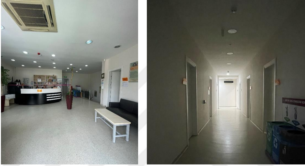
Şekil 4.19: KBÇKRSM Bekleme Alanı ve Koridor İklimlendirme Durumu
