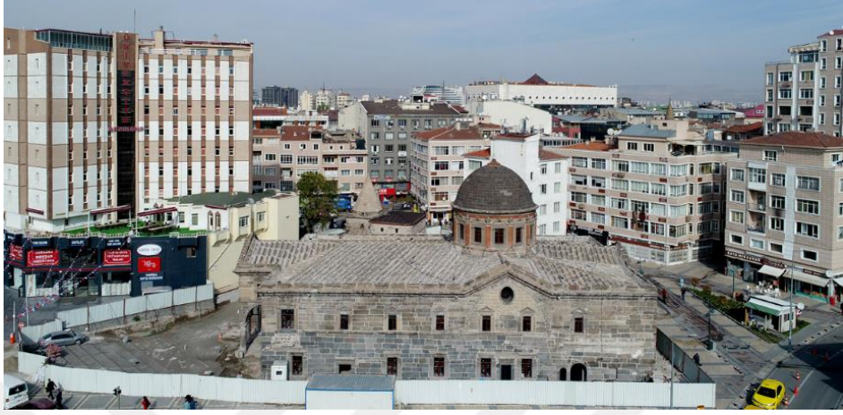
Şekil 4.5: Meryem Ana Kilisesi-Kent Kütüphanesi Yan Cephe Görünümü
