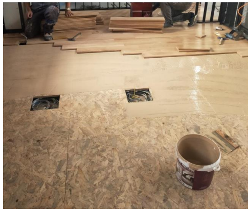
Şekil 4.8: Meryem Ana Kilisesi-Kent Kütüphanesi Restorasyon Projesi Zemin Kaplama Uygulaması
