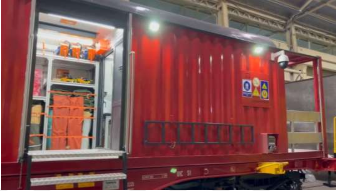
Şekil 4.20: KEK Raf Görseli ve Kontrol Odası Konteyner İç Kapısı Görünümü
