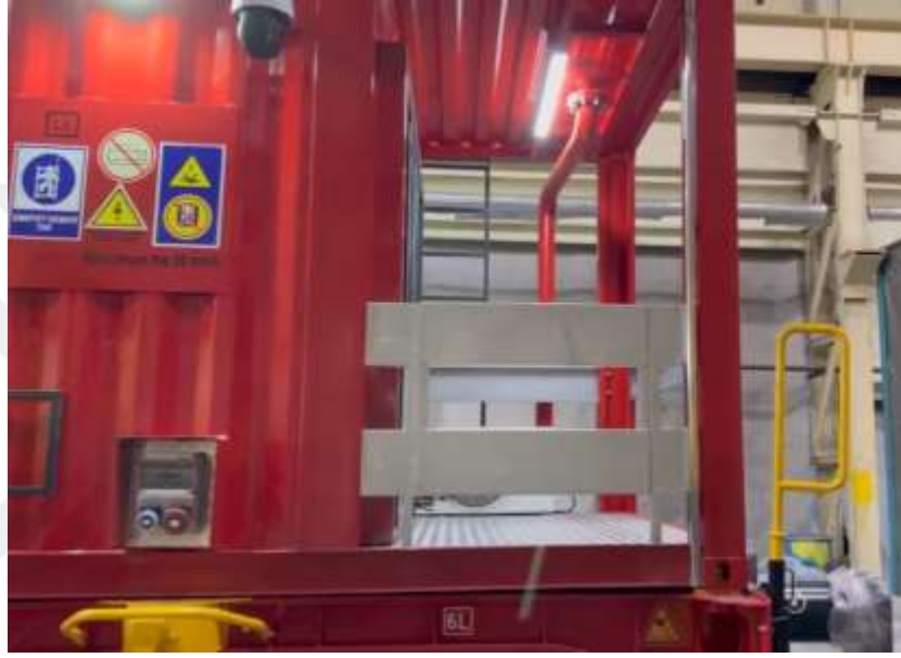
Şekil 4.21: KEK Platform (Sahanlık) Yan Cephe Görünümü
