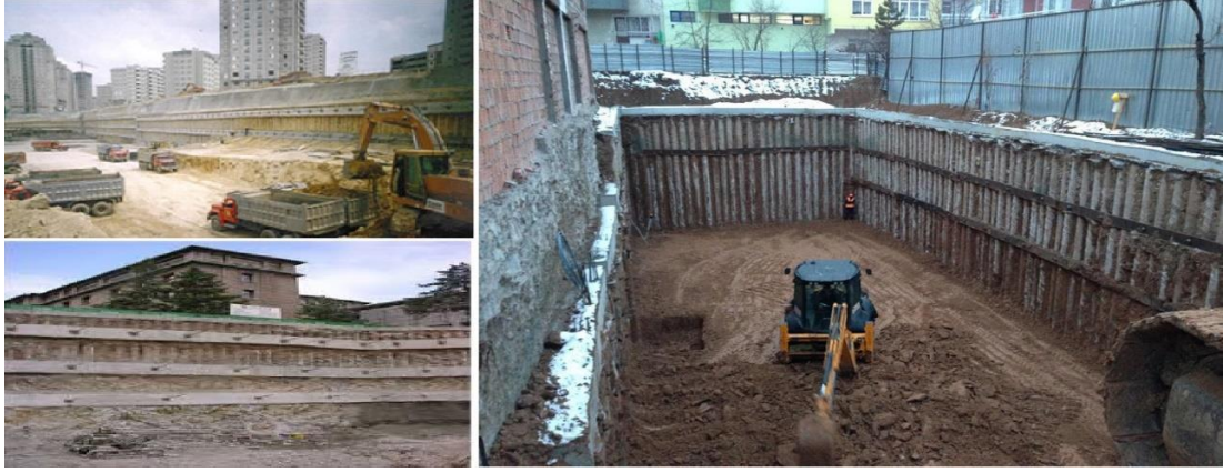
Şekil 2.14: Mini Kazık Duvar Örneği
