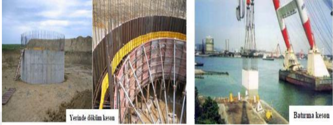
Şekil 2.9: Yerinde Döküm Keson, Batırma Keson
