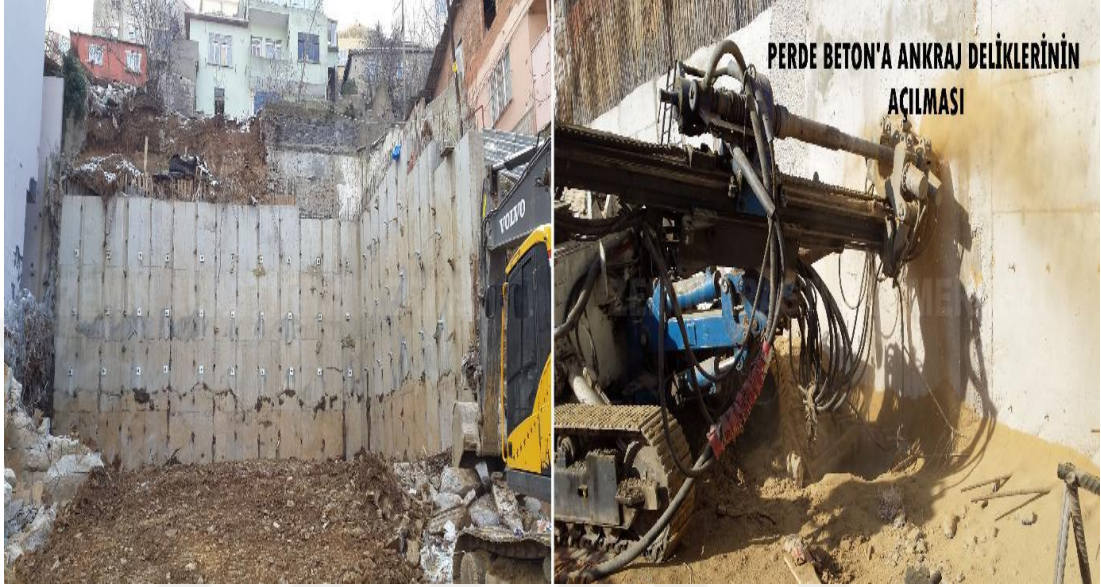
Şekil 2.15: Betonarme Kuyu Perde Uygulaması
