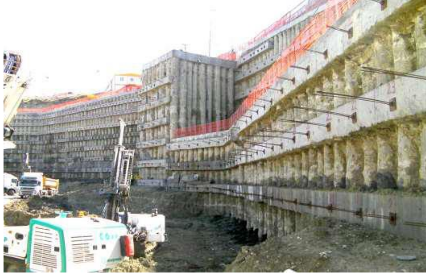
Şekil 2.11: Fore Kazıklı Duvar Örneği
