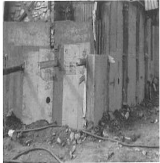
Şekil 2.19: Betonarme Perde Duvarlı Kuyu Temel
