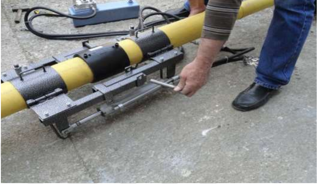
Şekil 2.15: Füzyon Kaynağı Uygulama İşlemi
