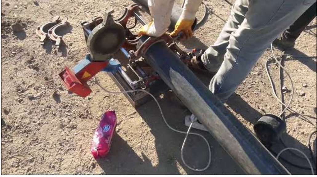
Şekil 2.3: Büyük Çaplı Plastik Kaynağı
