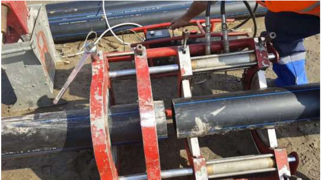
Şekil 2.9: Alın Kaynağı
