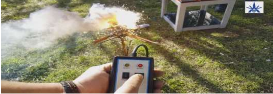
Şekil 2.13: Termo Kaynak Uygulamasında Ateşleme İşleminin Elektronik Pota Çakmağı ile Gerçekleştirilmesi
