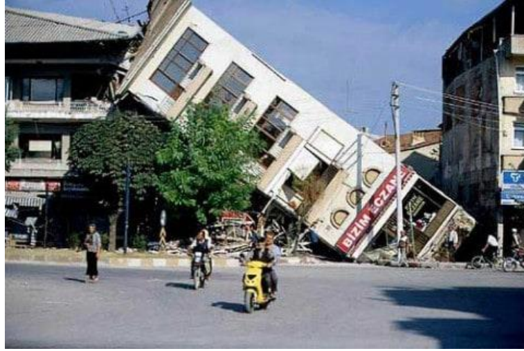
Şekil 2.6: 1999 Depreminde Sakarya İlinde Zemin Sıvılaşması Sonucuyla Yıkılan Yapı
