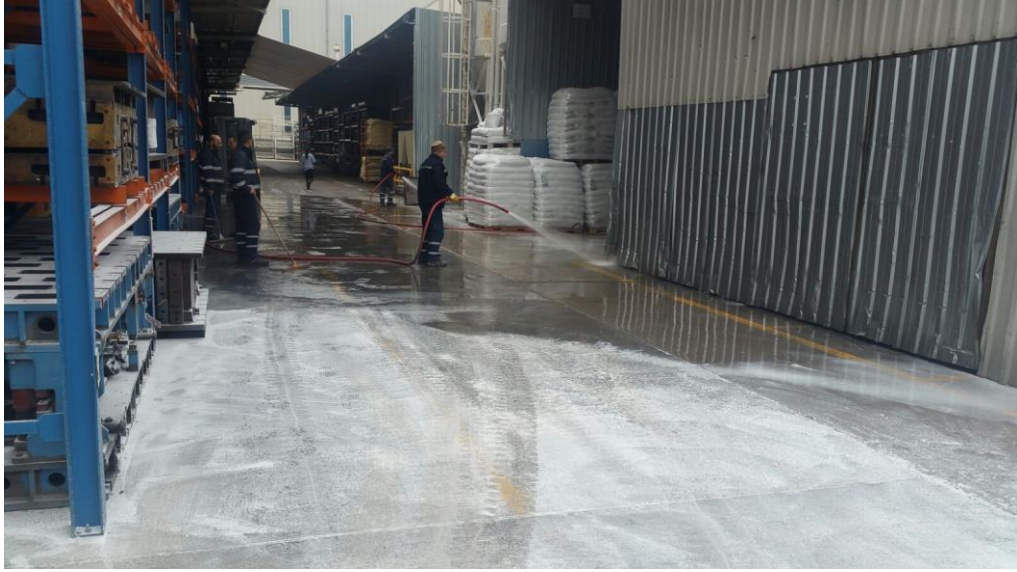
Şekil 5.44: Ramak Kalanın Yaşandığı Kalsit Taşması
