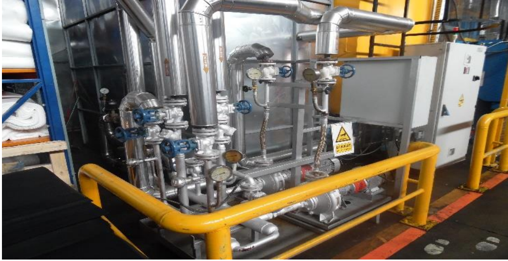
Şekil 5.7: Pres Makinesi Kızgın Yağ Boru Hatları
