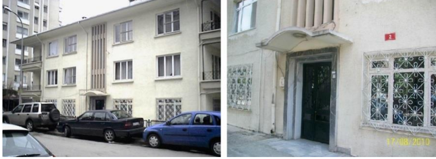
Şekil 3.38: Gülistan Sokak'tan Kuzeybatı Cehesi ve Giriş Kapısı Detayı
