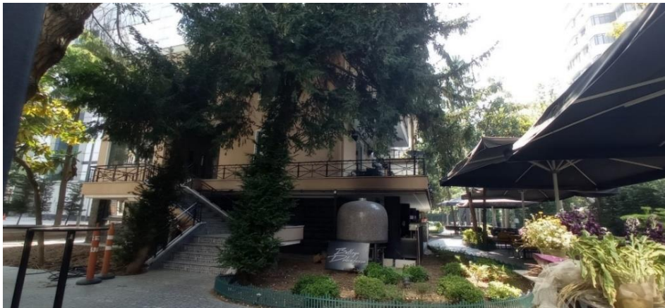
Şekil 3.14: Yapının Ömer Paşa Caddesine Bakan Cephesi ve Giriş Merdivenleri
