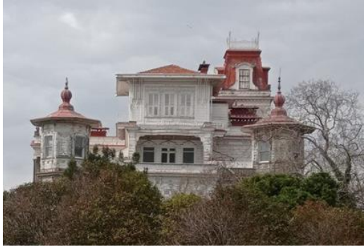
Şekil 2.7: Ragıp Paşa Köşkü
