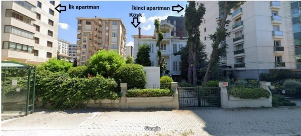
Şekil 3.9: Cafer Paşa Köşkü Ön Cehesi ve Yanındaki Yapılar
