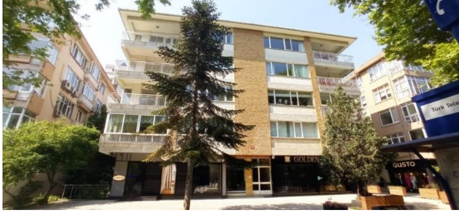
Şekil 3.70: Yapının Bağdat Caddesi cephesi
