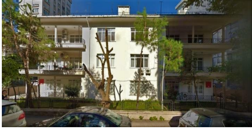
Şekil 3.36: Yapının Mehtap Sokak'tan Güneybatı Cephesi
