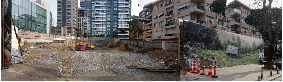
Şekil 3.75: Bağdat Caddesi'nden Yapının Hafriyat Alanı
