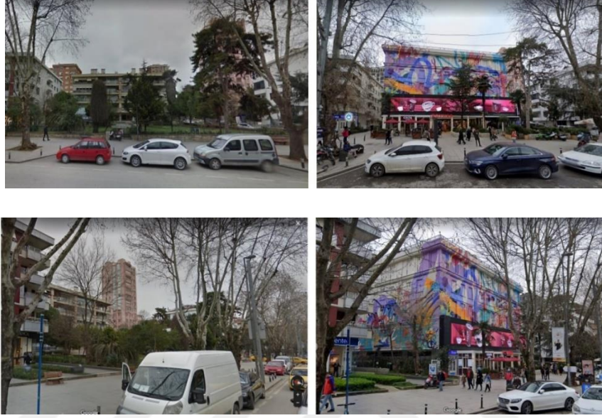
Şekil 3.53: Solda Erenköy Apartmanı ve Sağda Cadde Sınırına Yaklaşmış Ticari Yapının Görünüşleri
