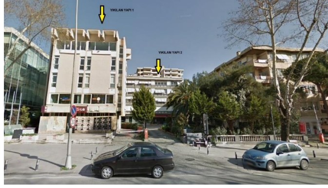
Şekil 3.77: Şen Apartmanı ve Arka Planda Önündeki Bahçesi ile Faik Bey Apartmanı
