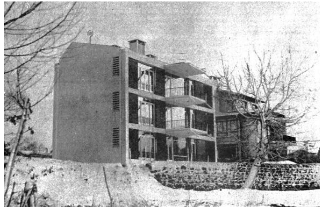
Şekil 2.41: Kalamış’taki Üç Katlı Apartmanın Ön ve Yan Cephesi
