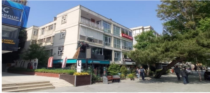
Şekil 3.54: Dilek Apartmanının Bağdat Caddesi'nden Görünüşü
