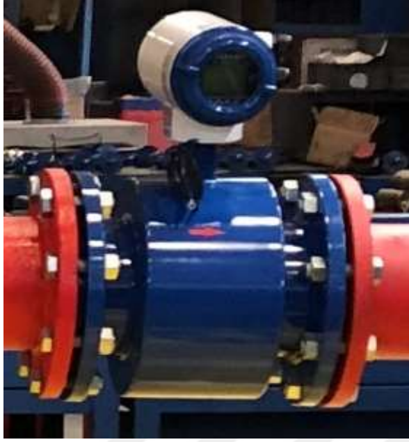
Şekil 5.12: DN150 mm Manyetik Debimetre
