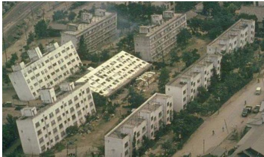
Şekil 2.15: 1964 Niigata depremi sonrası sıvılaşma kaynaklı hasara uğrayan yapılar
