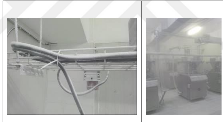
Resim 12: Şeker baskı ünitesinde toz birikimi (İstanbul 2015)
